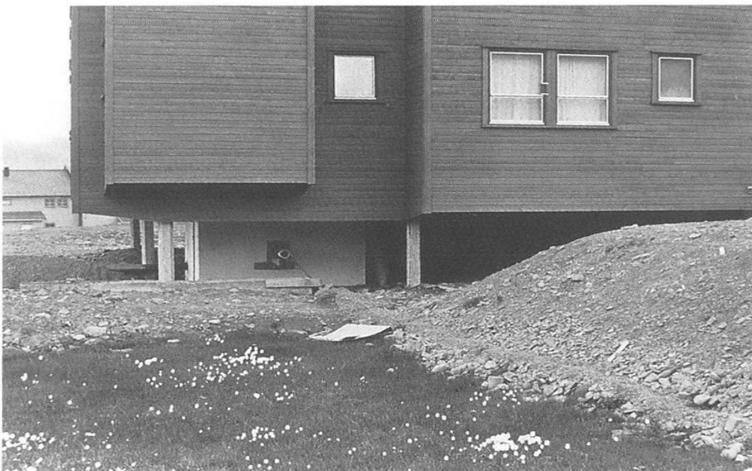
FIG. 14. — Les méthodes de protection contre la fusion du sol sont illustrées par cette photo prise à Longyearbyen au Spitzberg : constructions sur pilotis et remblaiement du sol avec des graviers et des sables.
