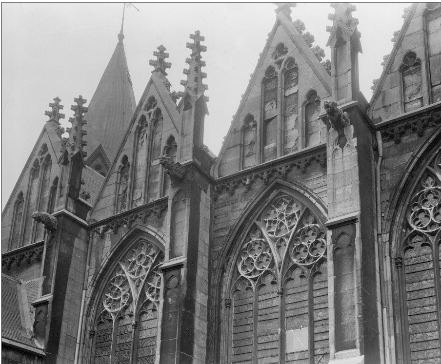
Fig. 9 : Vue détaillée du flanc sud de l'église. Cliché anonyme, 1954. © KIK-IRPA, cliché B153482.
