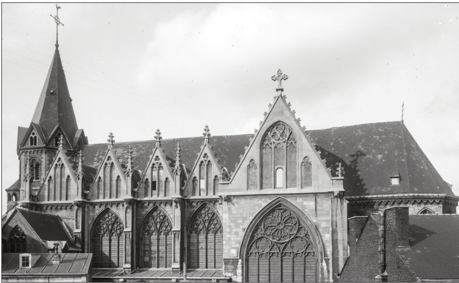
Fig. 5 : Vue générale du flanc sud de l'église. Cliché anonyme, 1917-1918. © KIK-IRPA, cliché B019215.
