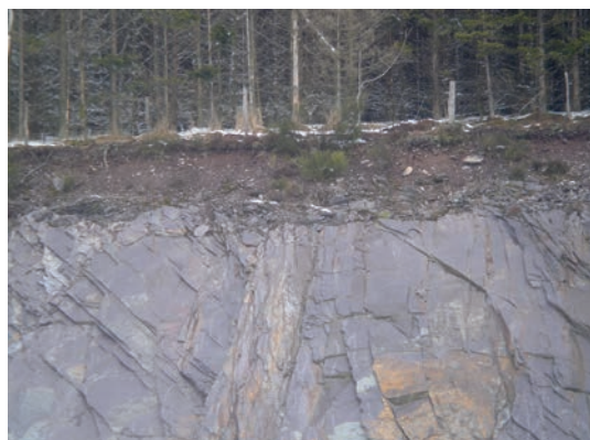
Fig. 3-4. – Coupe d'un front de carrière exploitant des schistes phylladeux du Paléozoïque inférieur dans le Massif de Stavelot-Venn montrant la faible épaisseur du colluvium.
