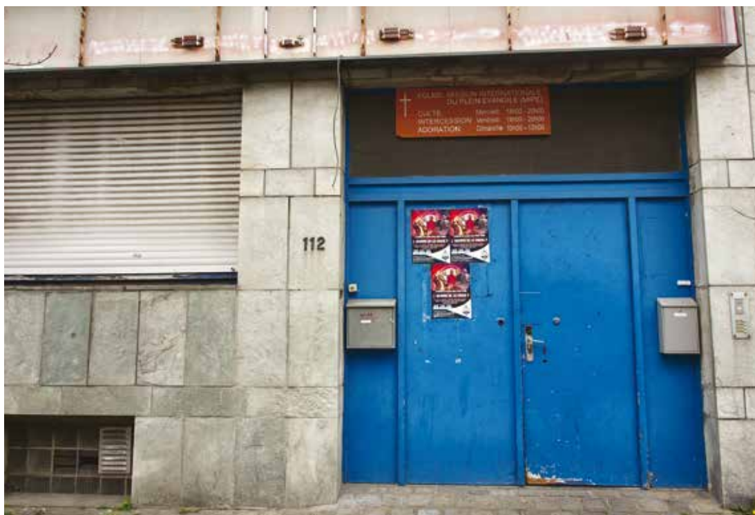
III. 5. Façade d'immeuble hébergeant plusieurs églises, rue de l'Instruction à Anderlecht (photo L. Druetz, 2018)
