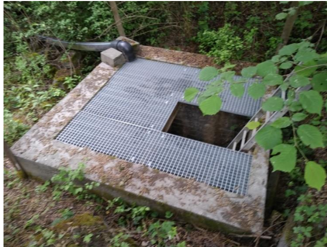
Fermeture et sécurisation de l'entrée du tunnel dans une carrière du projet
