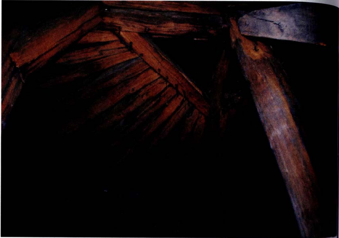
Figure 5 : Plateau d'enrayure dans la charpente au-dessus de l'abside (cliché P. Hoffsummer, 2009).
