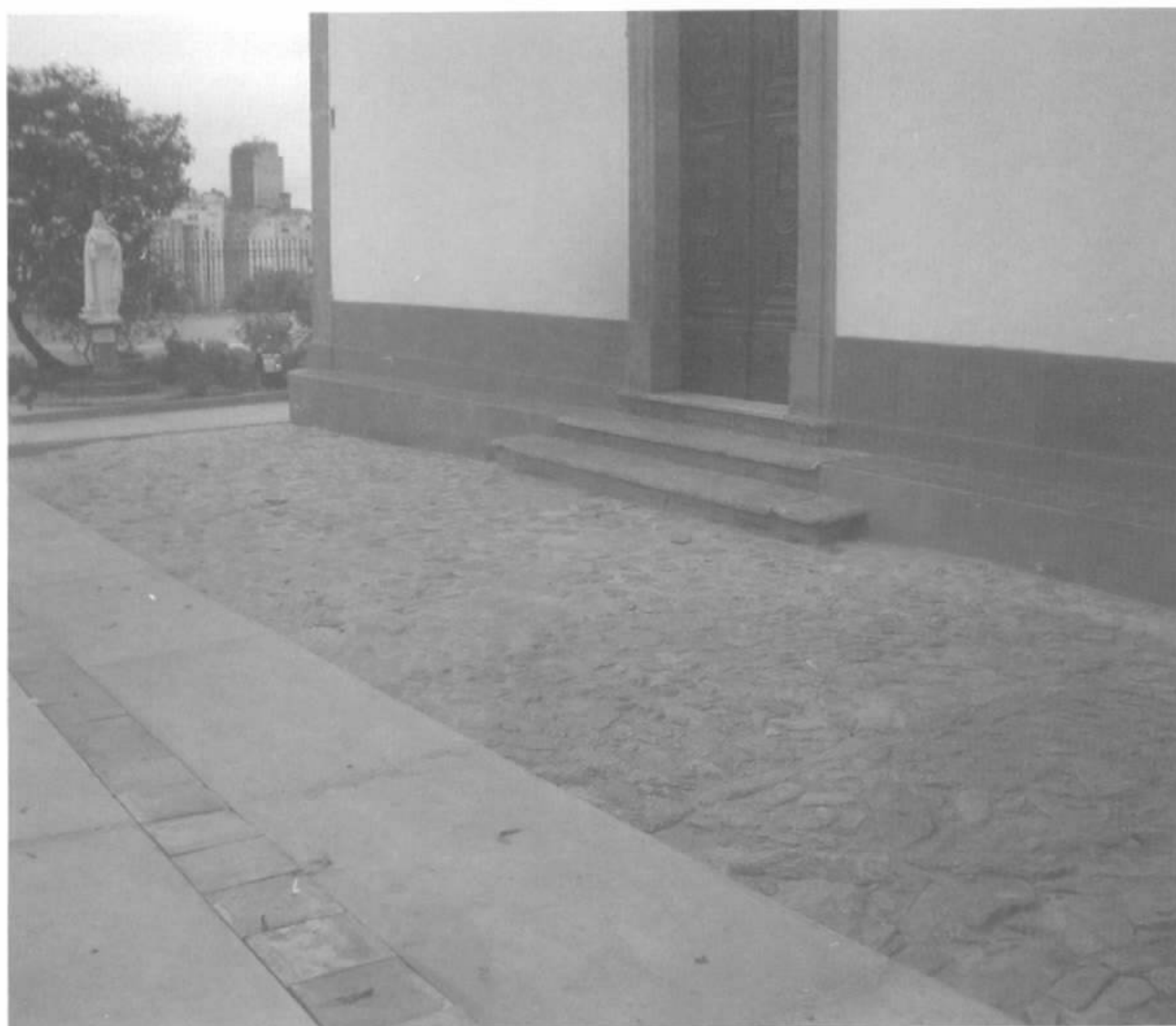
Figura 7 – Pé de moleque e calha incorporados ao projeto de restauro. Foto Márcia Braga, 2007.
