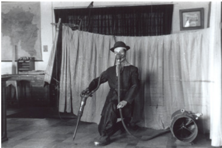
fig. 1 – Mannequin avec masque-ventilateur dans le bureau de dessin au siège Sartis de la S.A. des Charbonnages d'Hensies-Pommerœul, [vers 1938]. Source : SAICOM, fonds de la S.A. des Charbonnages d'Hensies-Pommerœul, Collection iconographique, santé HP 18.
