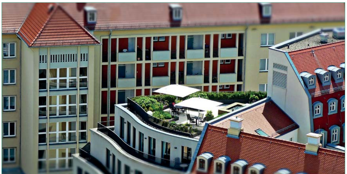
Fig. 48. Illustration de toitures terrasses ou jardins après rénovation
