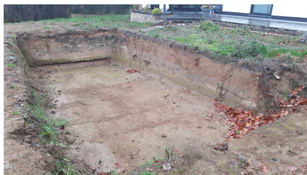
Figure 16 : Dépôts de pente et manteau d'altération caractéristiques du replat d'Embourg sous une couverture de déblais de construction dans une excavation de l'Avenue des Bouleaux, n°13, alt. 171 m.
