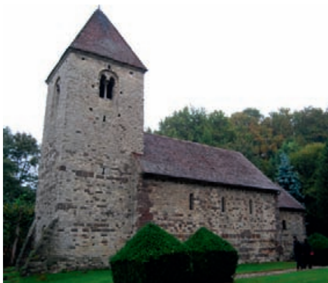
Fig. 1. Vue générale de la chapelle (cliché Armelle Weitz, 2013)
