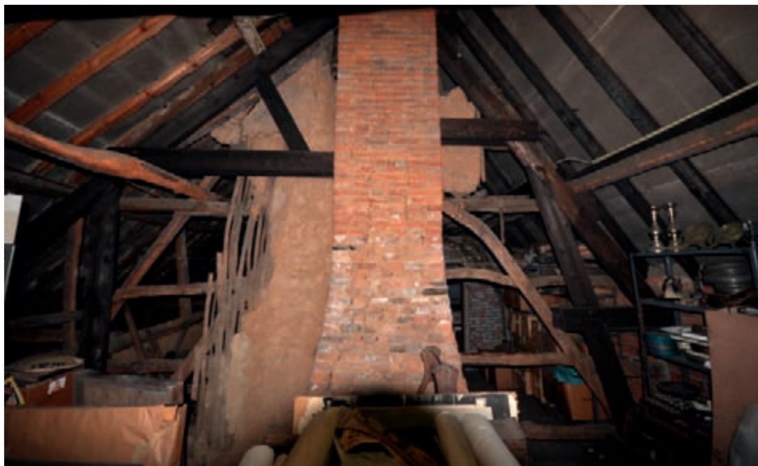
Fig. 8. Béguinage d'Anderlecht, cheminée centrale chauffant le rez-de-chaussée, état restauré mais comprenant des maçonneries datées du xv e siècle (P. Charruadas, P. Sosnowska © CReA-Patrimoine/ULB)
