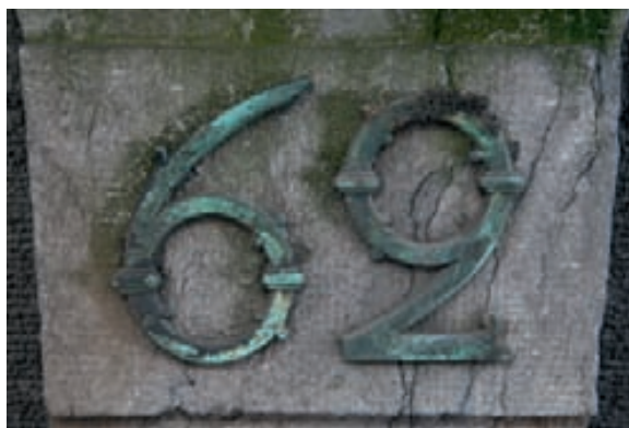
Le numéro de la maison, placé sur la clef de l'arc de la porte d'entrée, témoigne du soin apporté par l'architecte dans la cohérence stylistique de la composition de la façade. Laiton sur petit granit. (© Vincent Heymans – Cellule Patrimoine Historique).
