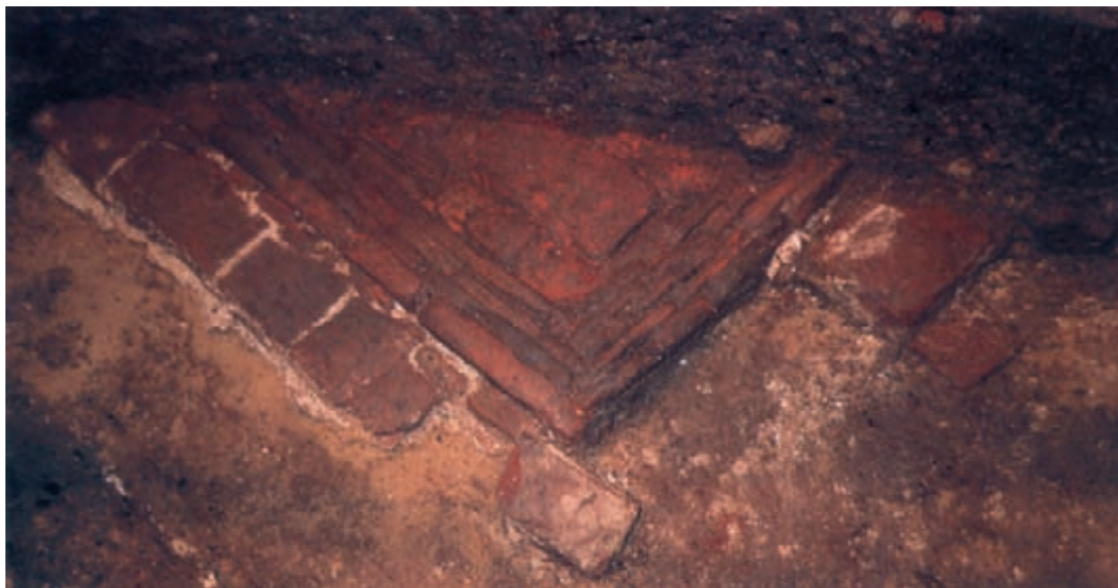
Fig. 1. Église des Riches-Clares, Bruxelles, pavement construit en briques et tuiles plates daté de la seconde moitié du XIII e siècle ou du premier quart du XIV e siècle (A. De Poorter © MRAH - DMS/SPRB)
