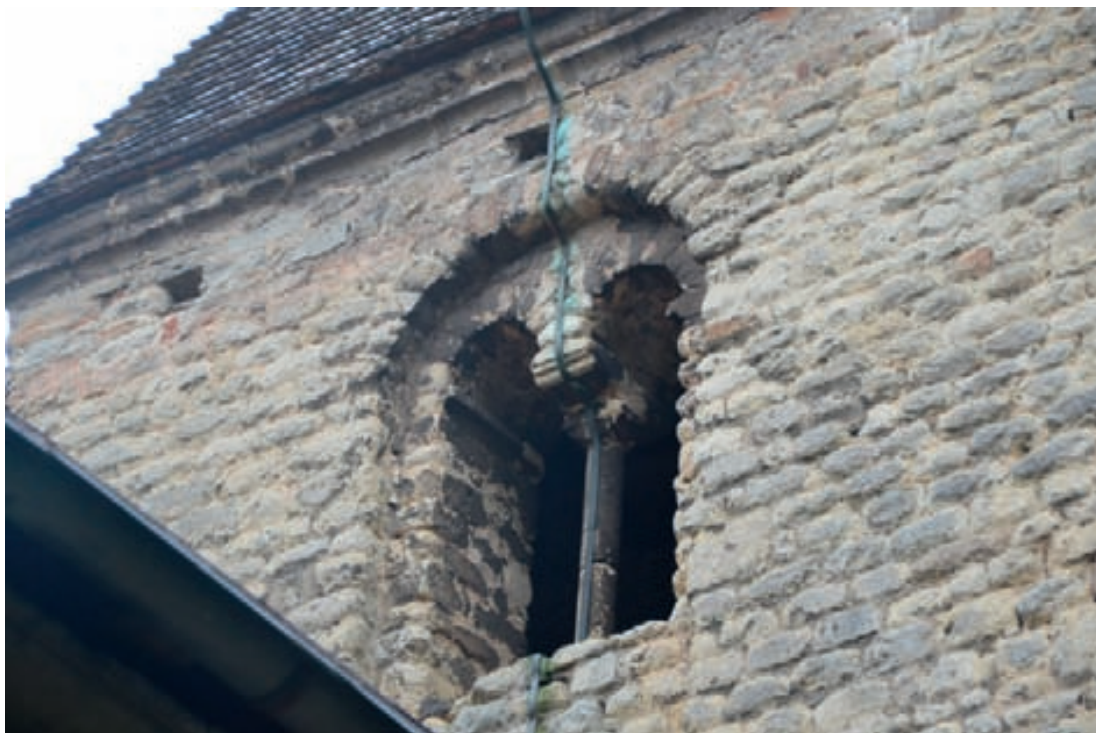
Fig. 3. Baie géminée de la tour, côté est, au-dessus de la nef (cliché Paulo Charruadas, 2013)
