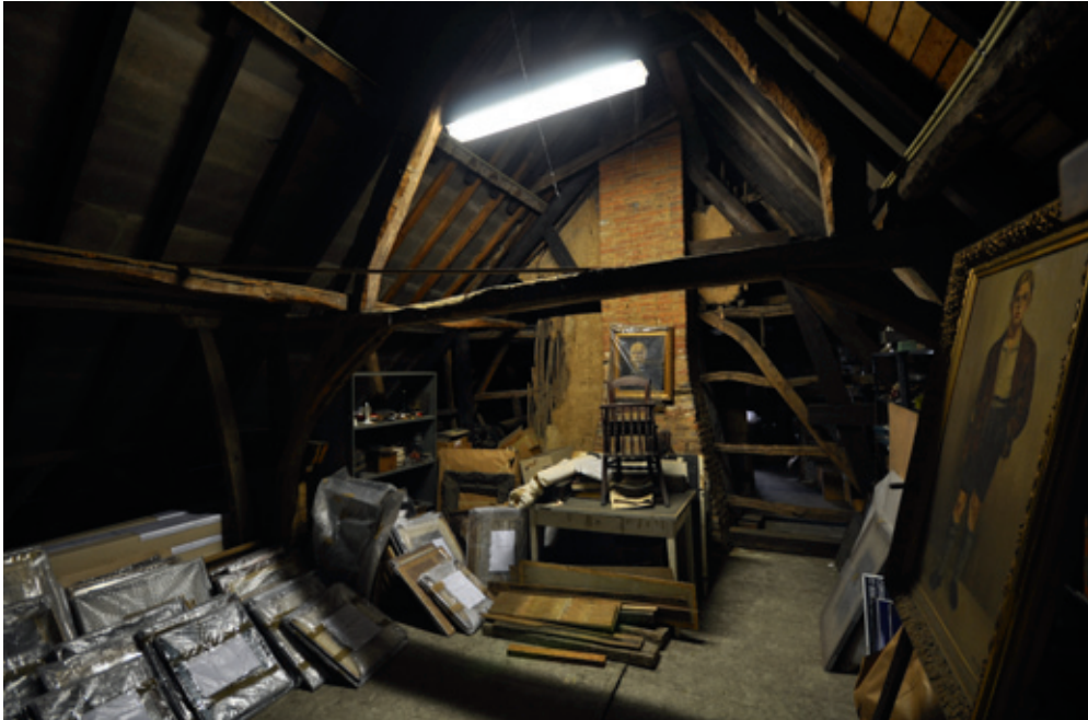
Figs. 8 et 8bis. Vues d'ensemble des fermes de charpente depuis les combles. © cliché Paulo Charruadas & Philippe Sosnowska, 2010
