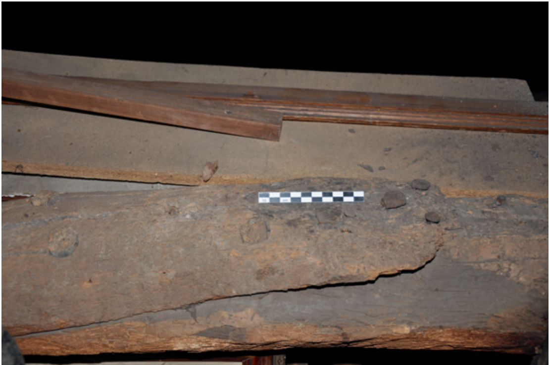
Fig. 20. Sablière haute du mur ouest du pan-de-bois. Détail de l'assemblage en sifflet chevillé, renforcé par des clous. © cliché Paulo Charruadas & Philippe Sosnowska, 2010
