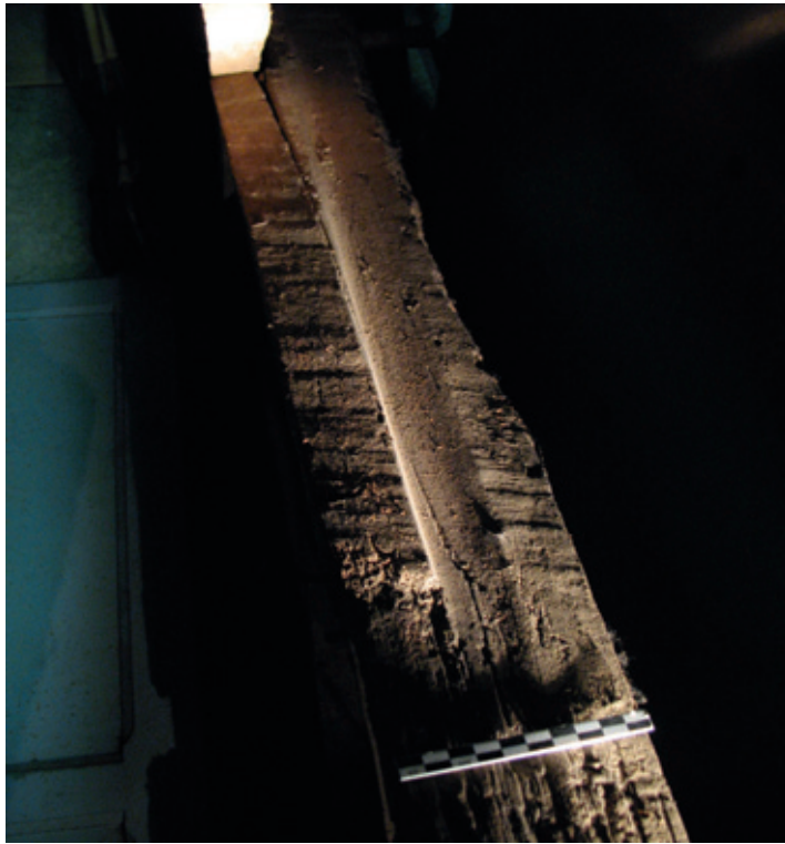
Fig. 12. Trace de coulissement d'un ancien volet dans l'ancienne façade-pignon sud. © cliché Paulo Charruadas & Philippe Sosnowska, 2010
