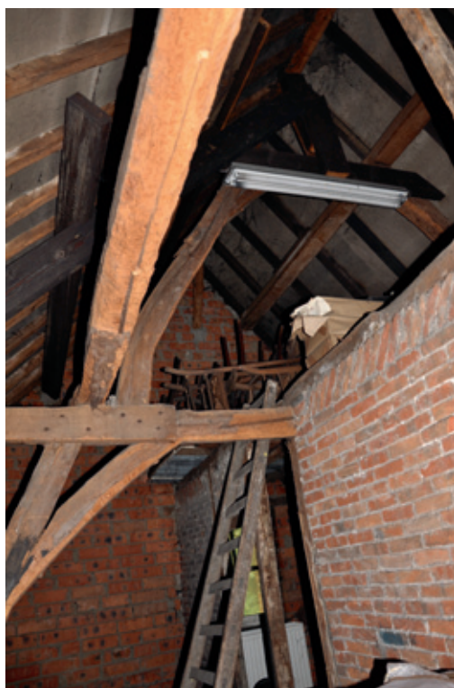
Fig. 14. Ferme II, prise depuis le sud. © cliché Paulo Charruadas & Philippe Sosnowska, 2010
