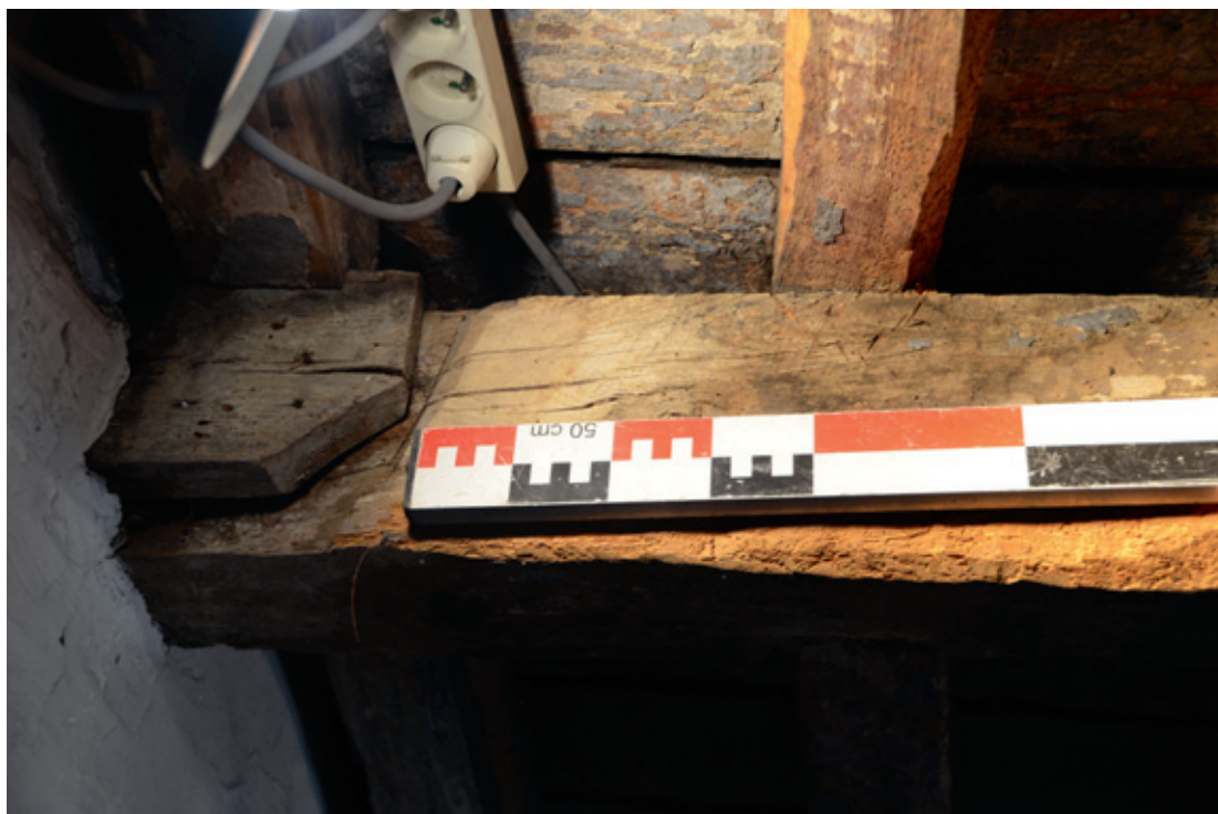
Fig. 9. Tenon passant de la ferme III. © cliché Paulo Charruadas & Philippe Sosnowska, 2010
