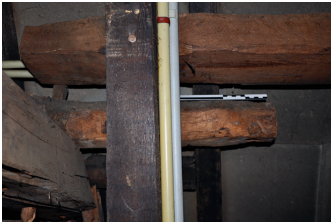
Fig. 11. Panne débordante couvrant l'ancienne façade-pignon sud. © cliché Paulo Charruadas & Philippe Sosnowska, 2010
