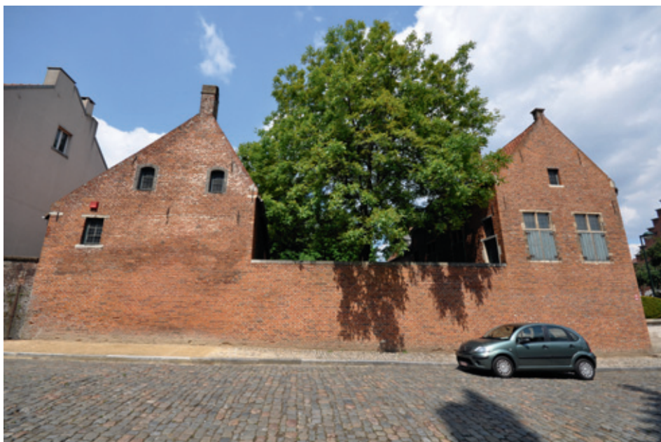
Fig. 2. Vue du site du béguinage depuis la rue du Chapelain au sud. © cliché Paulo Charruadas & Philippe Sosnowska, 2010
