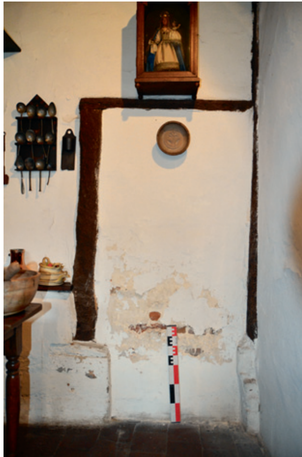
Fig. 21. Baie murée aménagée dans le mur ouest du pan-de-bois primitif. © cliché Paulo Charruadas & Philippe Sosnowska, 2010
