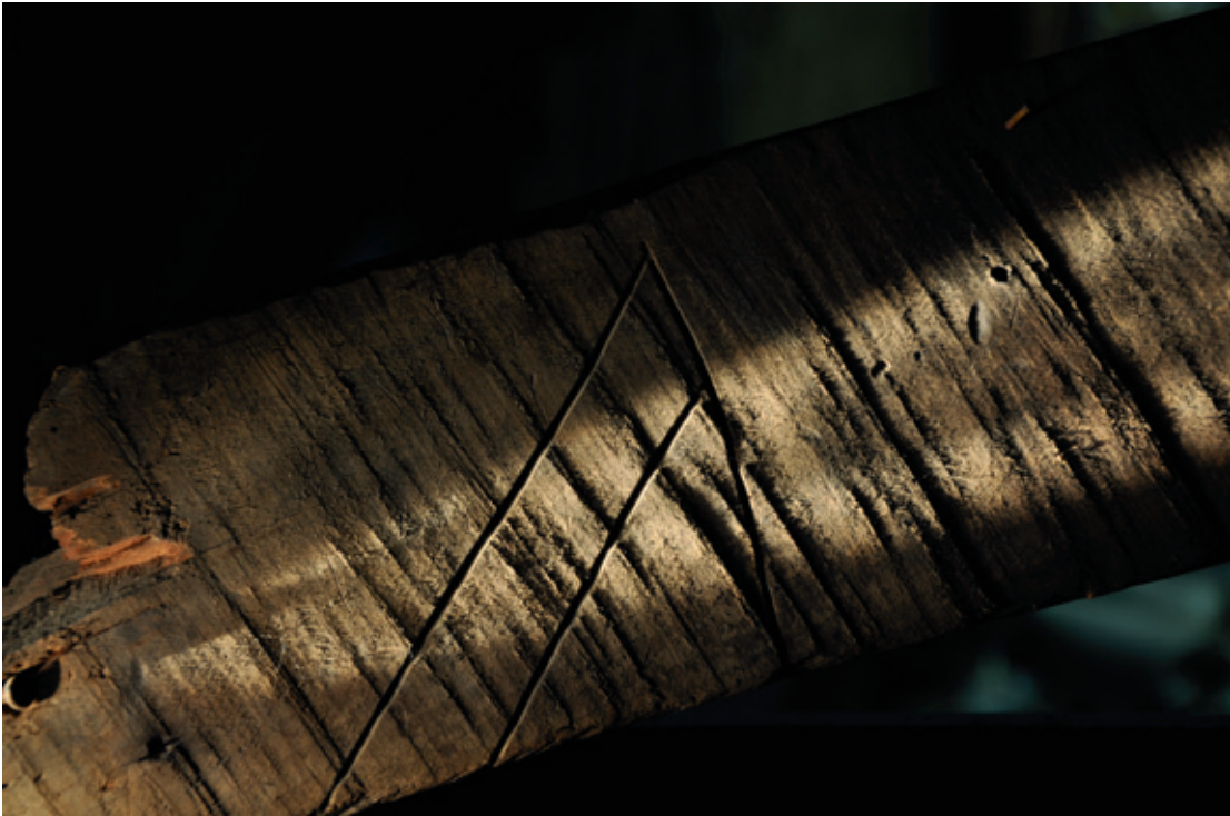
Fig. 27. Détail de la technique de débitage avec outil de type scie. © cliché Paulo Charruadas & Philippe Sosnowska, 2010
