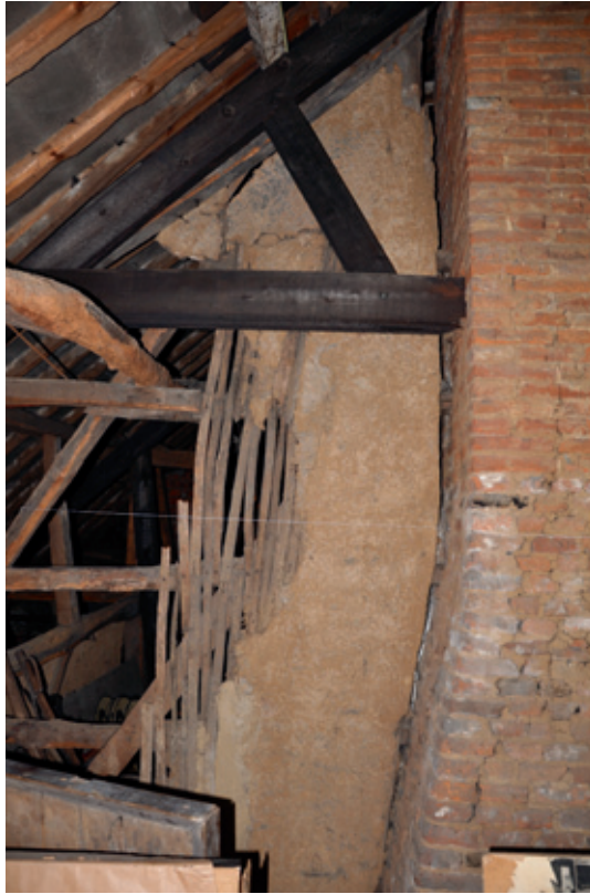
Fig. 23. Ferme III. Détail du lattis et des torchis. © cliché Paulo Charruadas & Philippe Sosnowska, 2010
