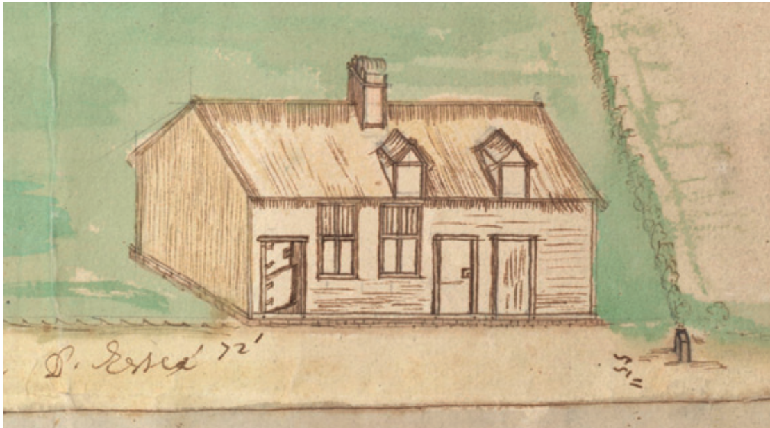
Fig. 29. Représentation d'une maison en pan-de-bois sur solin avec couverture en chaume située au hameau de Roussart à Waterloo. Détail de la carte figurative de l'arpenteur J. Laboureur en 1707.
