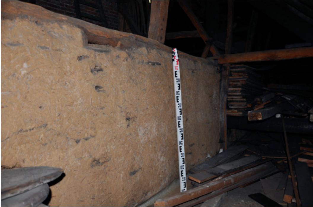
Fig. 22. Partie supérieure de la façade occidentale conservant clayonnage et torchis. © cliché Paulo Charruadas & Philippe Sosnowska, 2010
