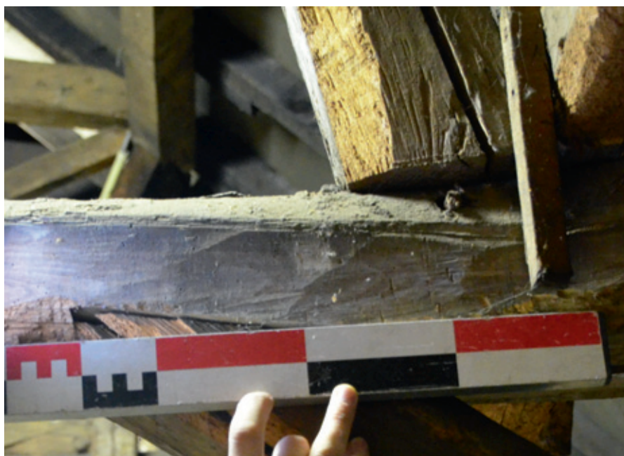
Fig. 26. Détail de la technique de débitage avec outil de type hache. © cliché Paulo Charruadas & Philippe Sosnowska, 2010
