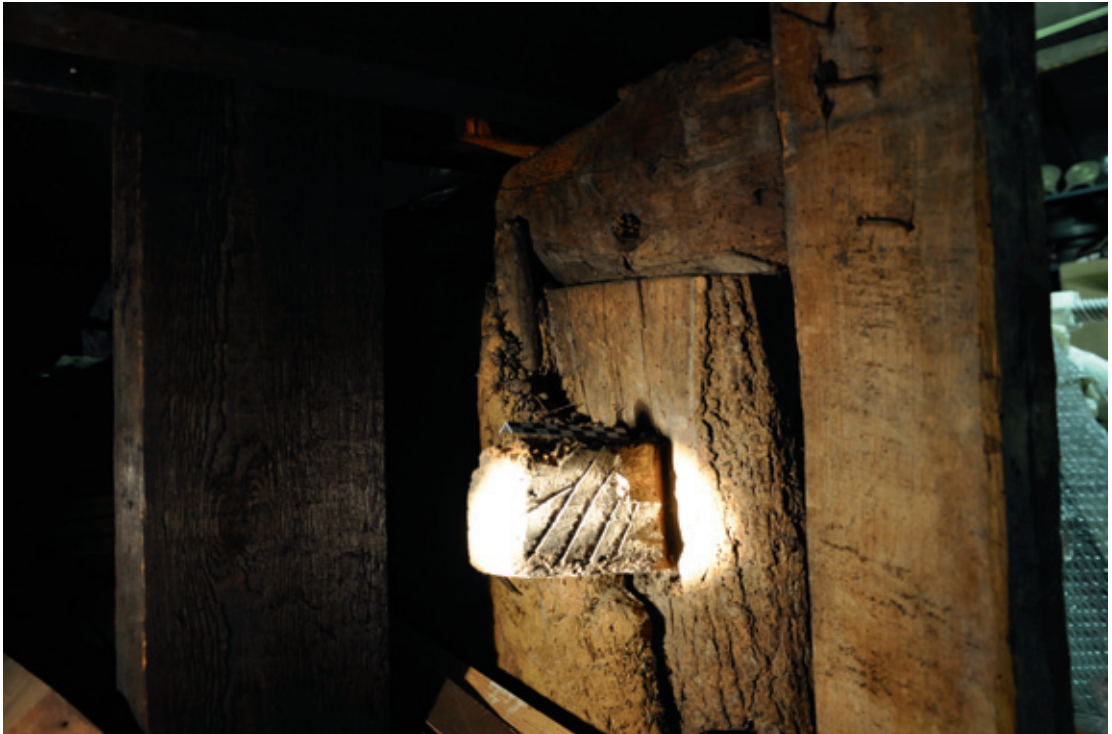
Fig. 24. Tenon passant solidarisant la ferme IV au poteau montant. Tenon contre-marqué IV. © cliché Paulo Charruadas & Philippe Sosnowska, 2010
