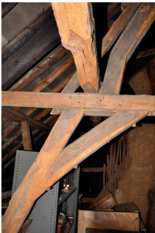
Fig. 16. Ferme IV. Détail des assemblages de l'aiselier à l'arbalétrier et au faux-entrait. © cliché Paulo Charruadas & Philippe Sosnowska, 2010
