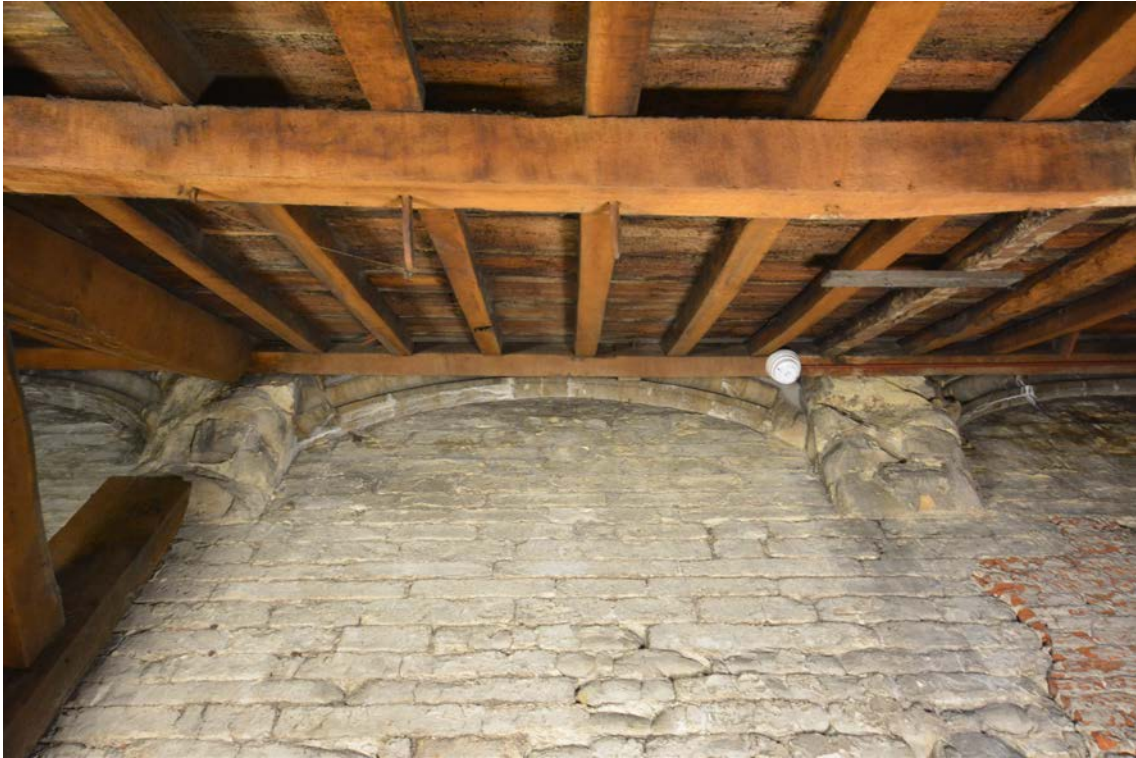
Fig. 14 – Aile orientale, façade ouest sur cour, corbeau soutenant un arc. Les blocs abîmés portent des traces évidentes de rubéfaction. Si le premier claveau témoigne de la disposition originale, le reste de l'arc est le fruit d'une restauration (S. Byl, F. Huyvaert © ULB - VdB).
