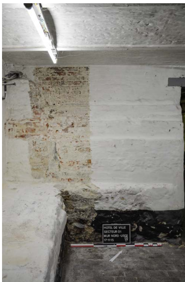
Fig. 2 – Noyau I, vue d'ensemble du mur ouest, comprenant un socle en moellon, une maçonnerie associée à un piédroit de briques ainsi qu'une fondation en escalier venant perturber l'ensemble (S. Byl, F. Huyvaert © ULB - VdB).
