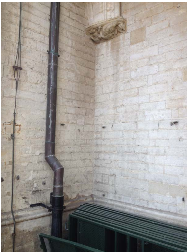
Fig. 19 – Aile ouest, rez-de-chaussée, harpage des maçonneries de la galerie et de la tour, (P. Sosnowska © ULB - VdB).
