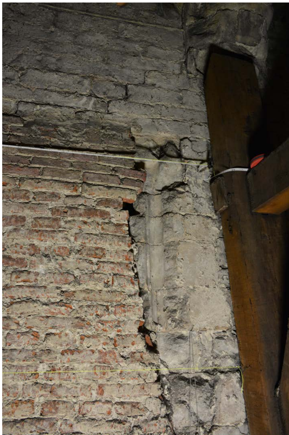
Fig. 15 – Aile orientale, façade ouest sur cour, détail du piédroit sud de la fenêtre esseulée (S. Byl, F. Huyvaert © ULB - VdB).
