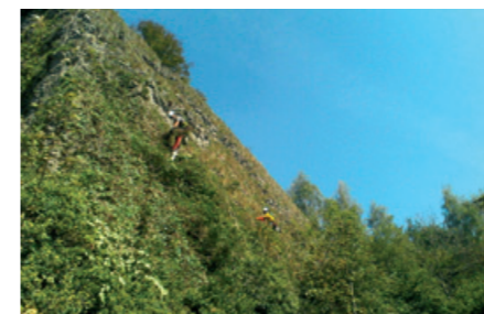
Intervention d'alpinistes sur la Grande Roche en septembre 2014
