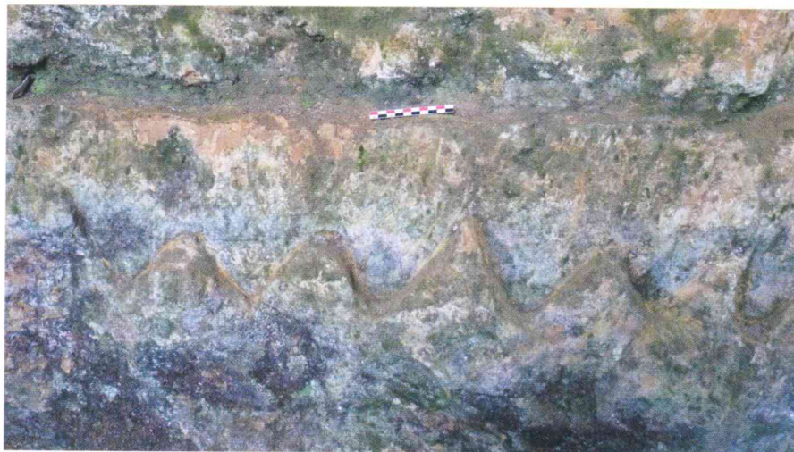
Fig. 10 : Carrière souterraine de Dom-le-Mesnil, traces d'extraction au coin conservées à l'entrée de la carrière (E. Baillieul).
