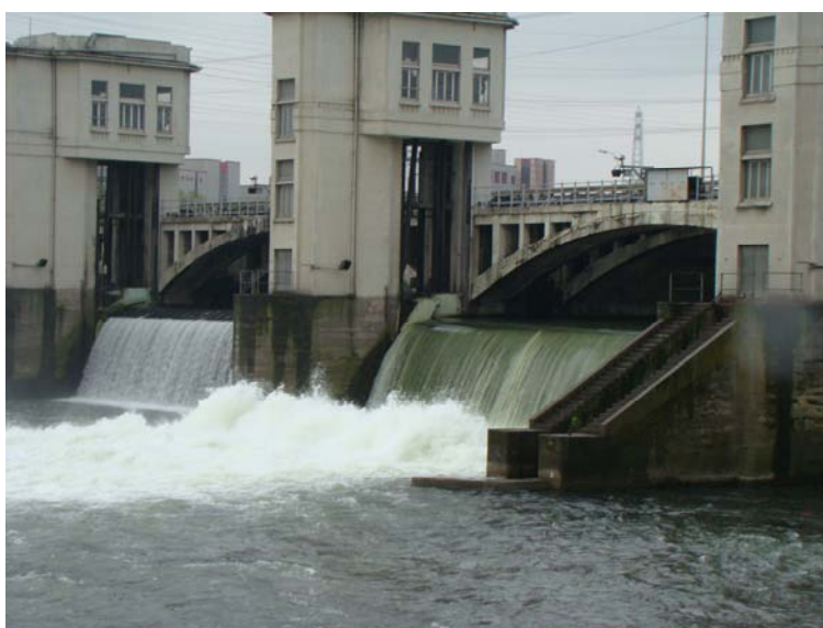
Figure 3. Concentration d'un débit réservé de 50 m 3 /s sur un déversoir unique du barrage de Monsin en 2008 : condition la plus favorable à la dévalaison des smolts en avril-mai.
