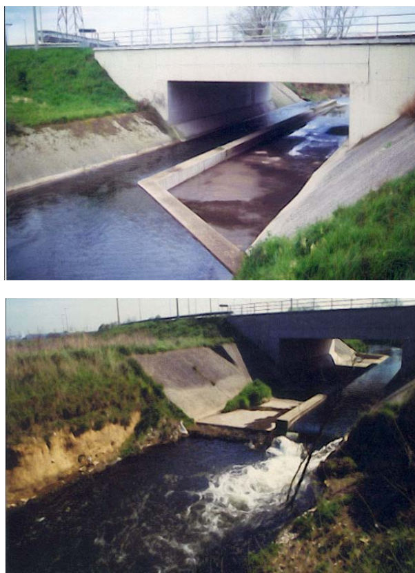
Figure 10. Site de la Berwinne à hauteur d'un passage sous routier à Moelingen : (au-dessus) rendu aisément franchissable en remontée par toutes les espèces de poissons et (en-dessous) dans la situation antérieure à la réalisation de l'aménagement
