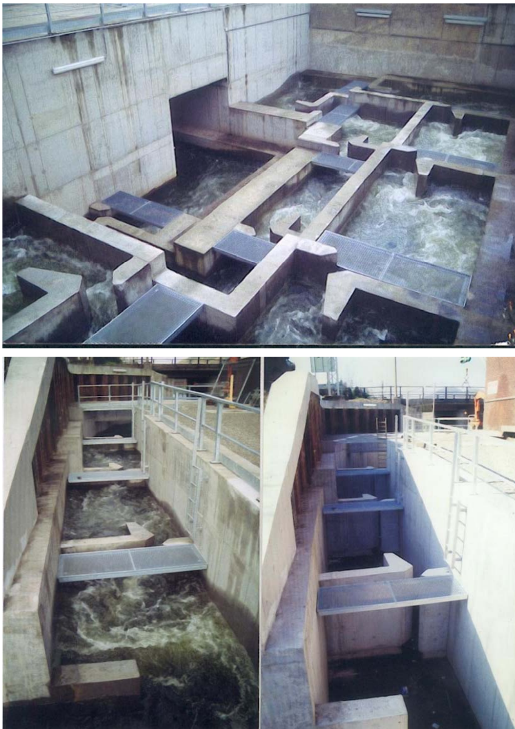
Figure 2. Parties inférieure (au-dessus) et supérieure (en-dessous) de l'échelle à poissons à bassins du barrage de Monsin-Liège sur la Meuse.
