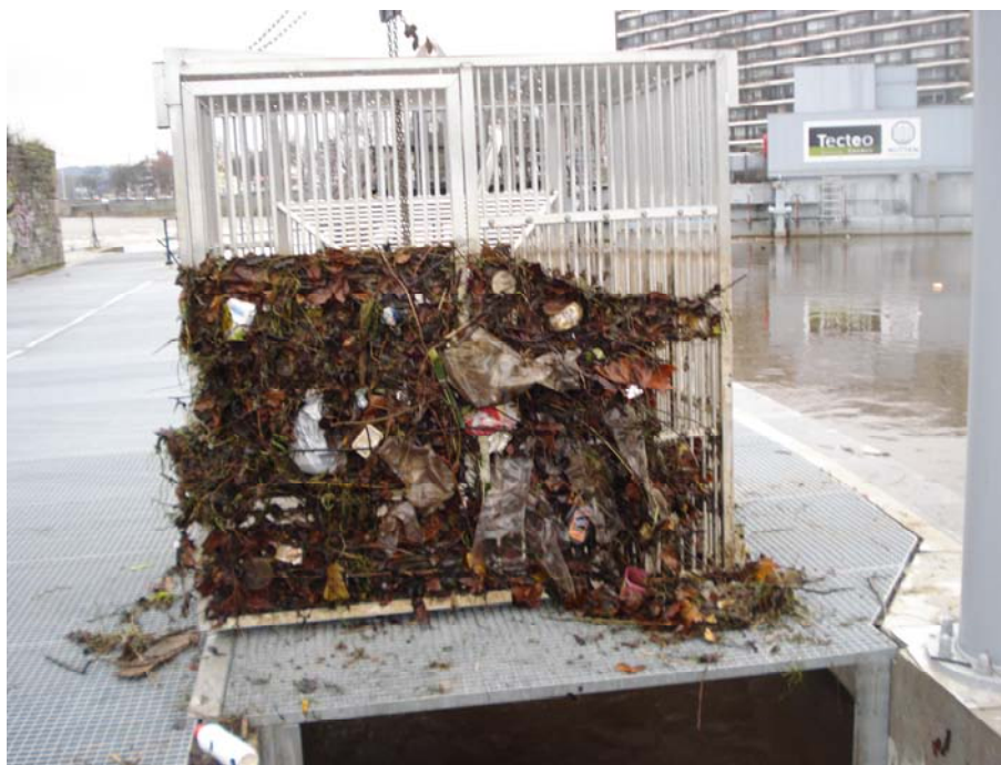
Figure 6. Colmatage de la face amont de la cage de capture par les déchets flottants.
