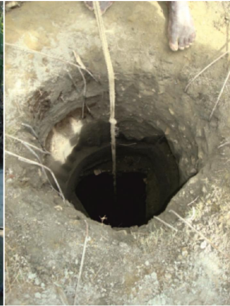
Figure 8 : Puits creusé aux abords du lac Béthanie à Pendiassou (P.M.).
