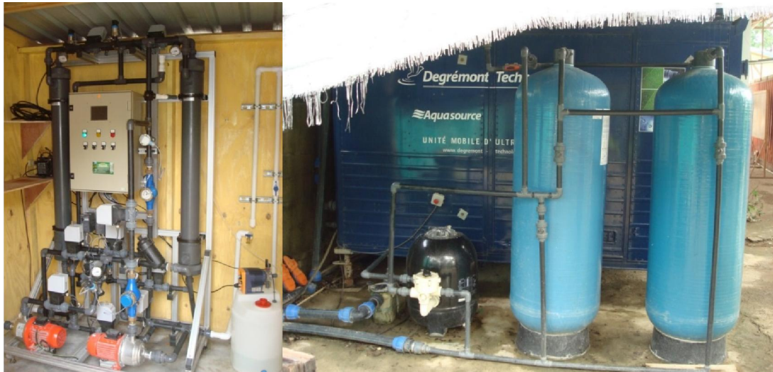
Figure 10 : Ultra-filtration : Petite unité pour filtrage d'eau de puits (PFI/PSI Saintard) et unité de filtrage du lac de Béthanie (PFI/PSI Pendiassou) ©P.M.
