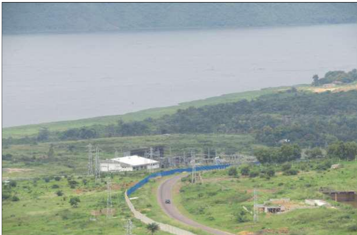
Figure 40 : Vue de la station électrique de Maluku (Sosider)
