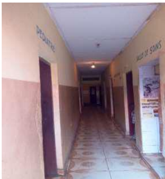
Figure 58 : Couloir donnant accès aux salles du CH Sephora
