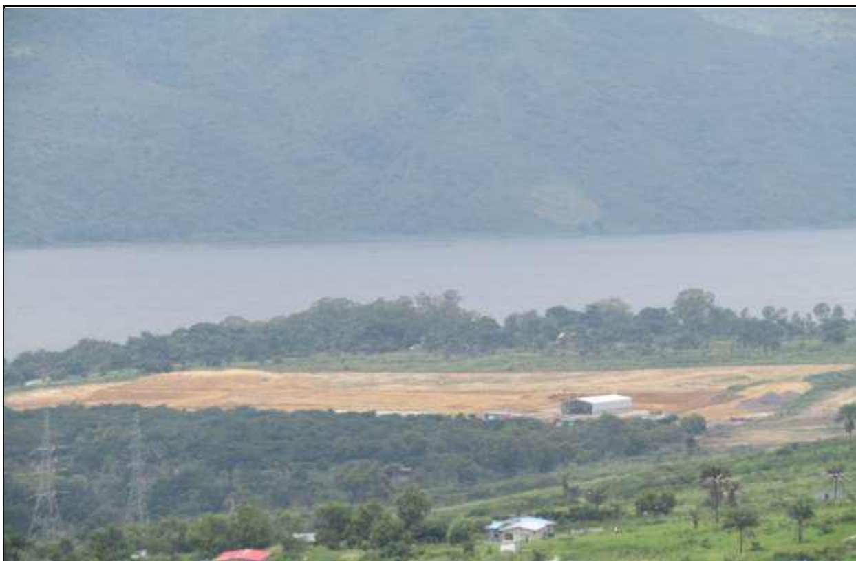
Figure 44 : Vue de premiers travaux de la ZES (le premier hangar)
