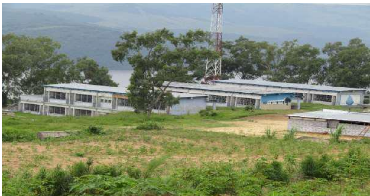
Figure 67 : Vue panoramique de l'institut de Maluku
