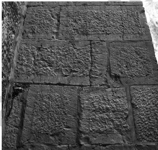
Fig. 11. Parements du contrefort oriental de la tour nord, restaurés à la fin du xv e siècle (© A. Baudry)
