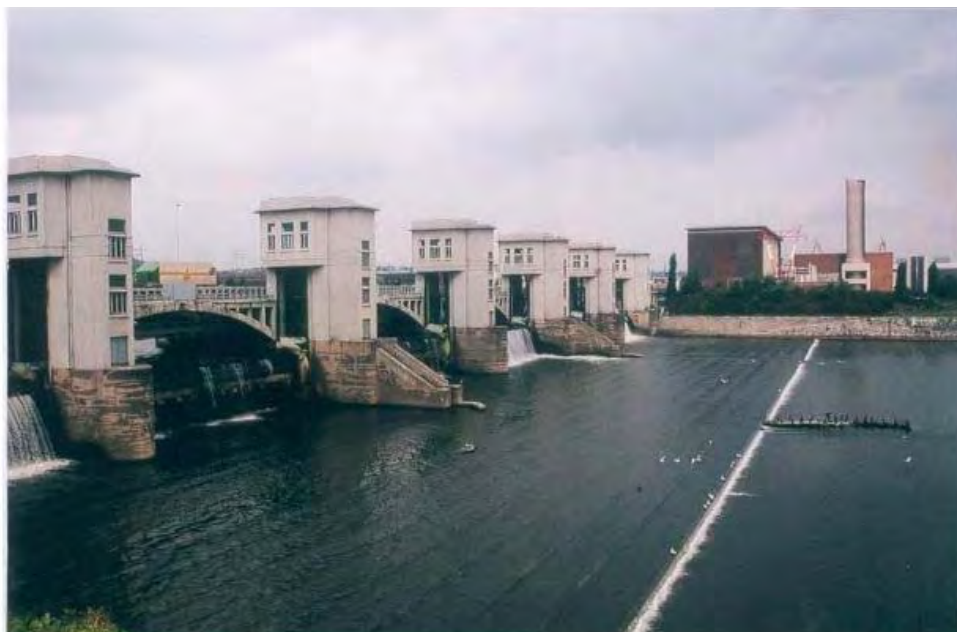
Figur 30. Exemple de barrage de navigation sans écluse sur la Meuse en Wallonie
