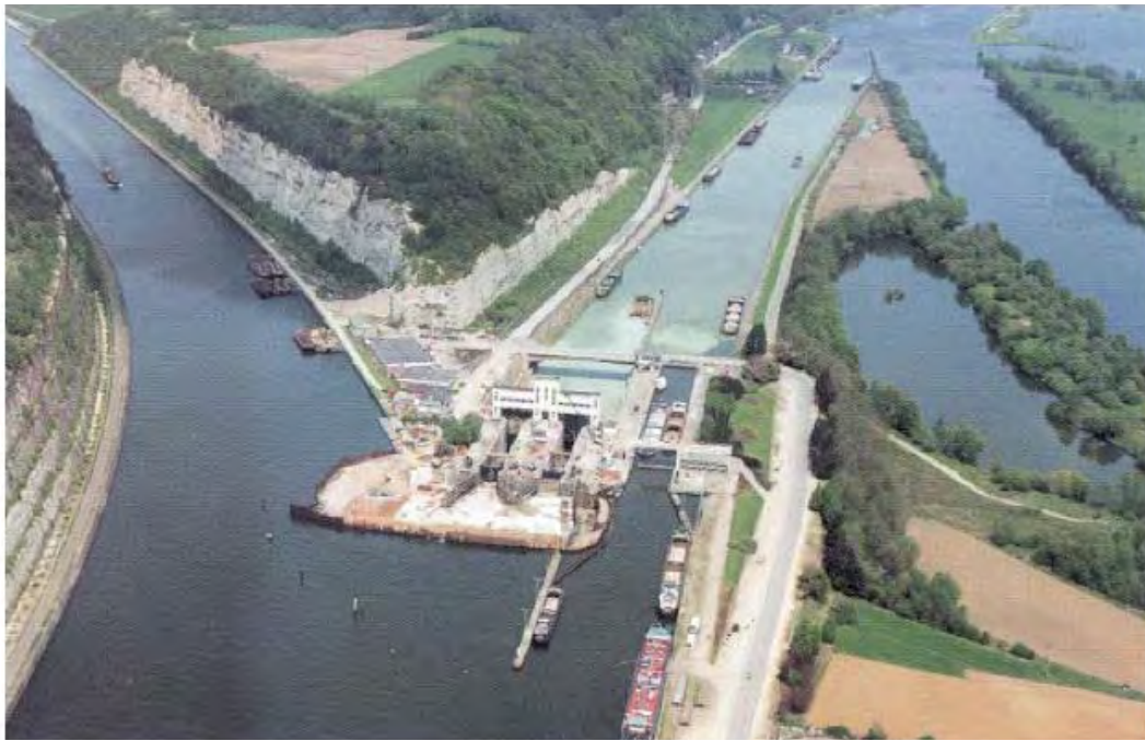
Figur 40. Canal Albert de liaison Meuse-Escaut
