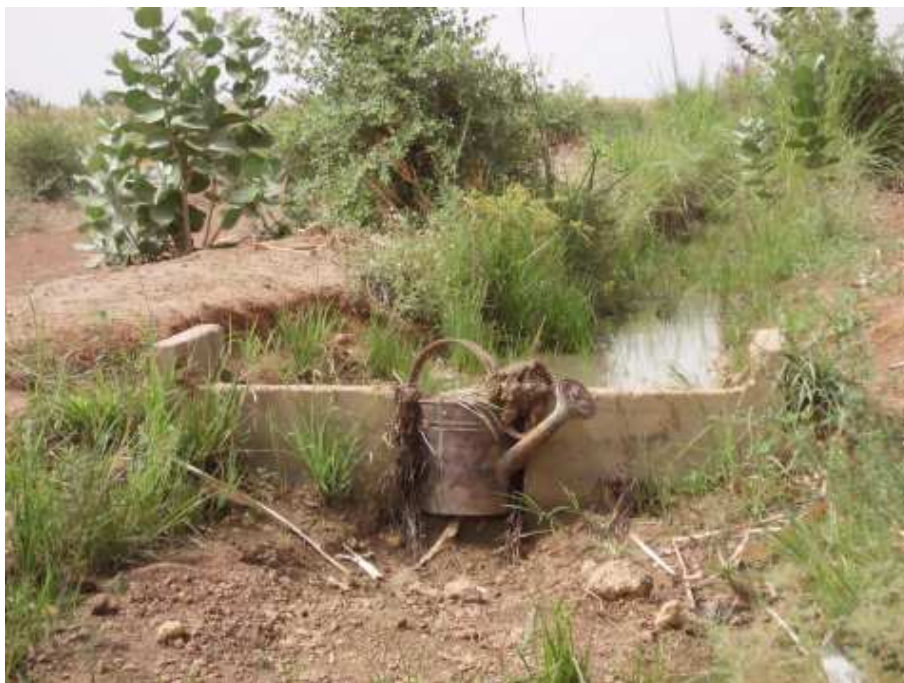
Figure 27 : Canal enherbé dans la Vallée du Sourou. Absence de vannette de régulation remplacée par un arrosoir (Photo D. Kambou)
