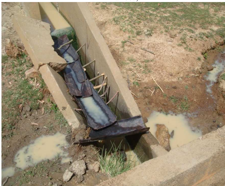
Figure 36 : Vue partielle du canal primaire du périmètre de Lantagogo ; Dégradation et installation d'un dispositif sommaire parallèle de canalisation de l'eau. (Photo D. Kambou)
