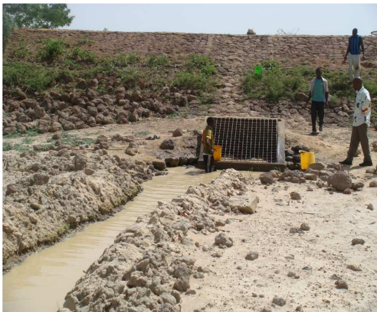
Figure 35 : Ouvrage de prise d'eau dans le barrage de Lantaogo en assèchement (Photo D. Kambou)
