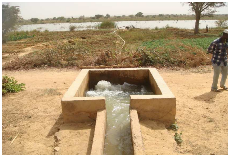
Figure 38 : Refoulement de l'eau pompée à partir du réservoir vers le canal primaire du périmètre de Rassomdé . (Photo D. Kambou)
