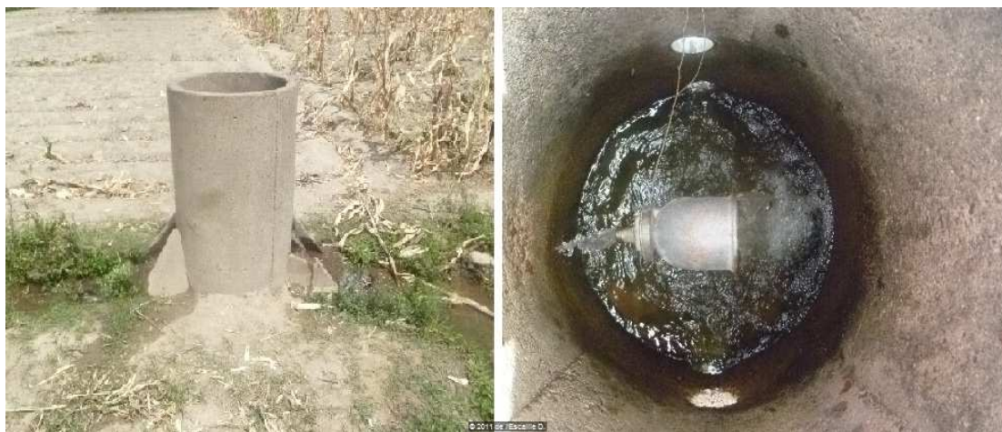
Figure 30 : Canne de sortie : vue latérale (à gauche) et vue en plan (à droite) (Photos D. Kambou)
