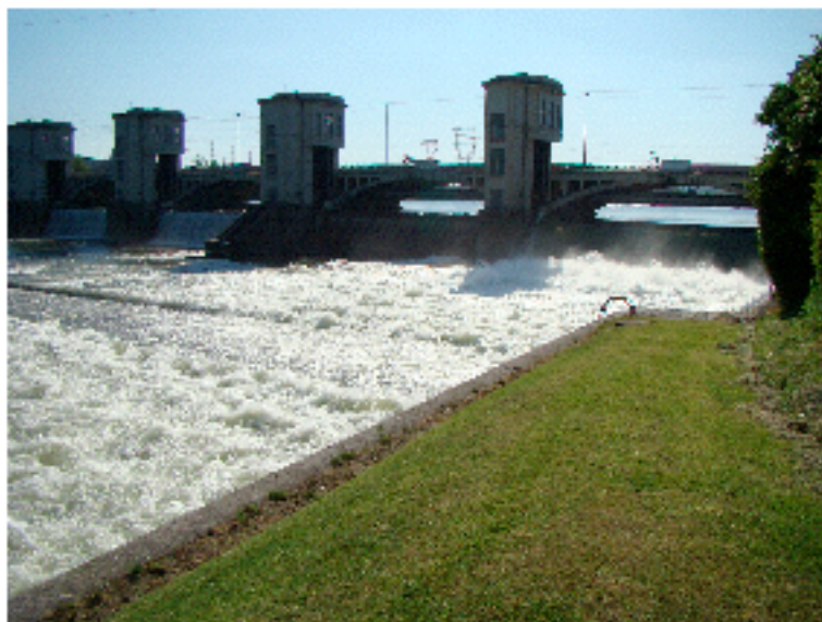
Photo 1/3. Déversement expérimental d'un débit de 60 m 3 /s opéré les 5-6 mai 2008 sur le pertuis n° 1 pour favoriser la dévalaison des smolts radio-marqués. Débit total de la Meuse : 245-259 m 3 /s.
