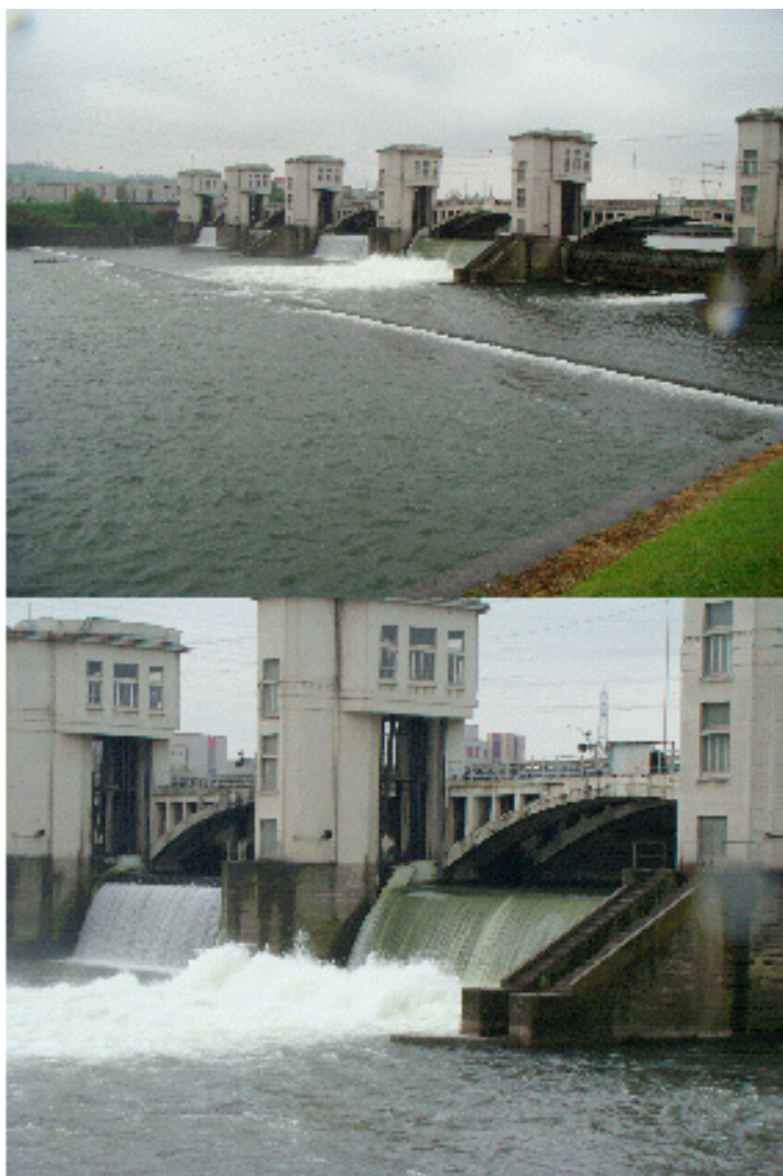
Figure 1/2. Déversement expérimental d'un débit de 30 m 3 /s opéré les 28-29 avril 2008 pour favoriser la dévalaison des smolts radio-marqués. Débit total de la Meuse : 310 m 3 /s.
