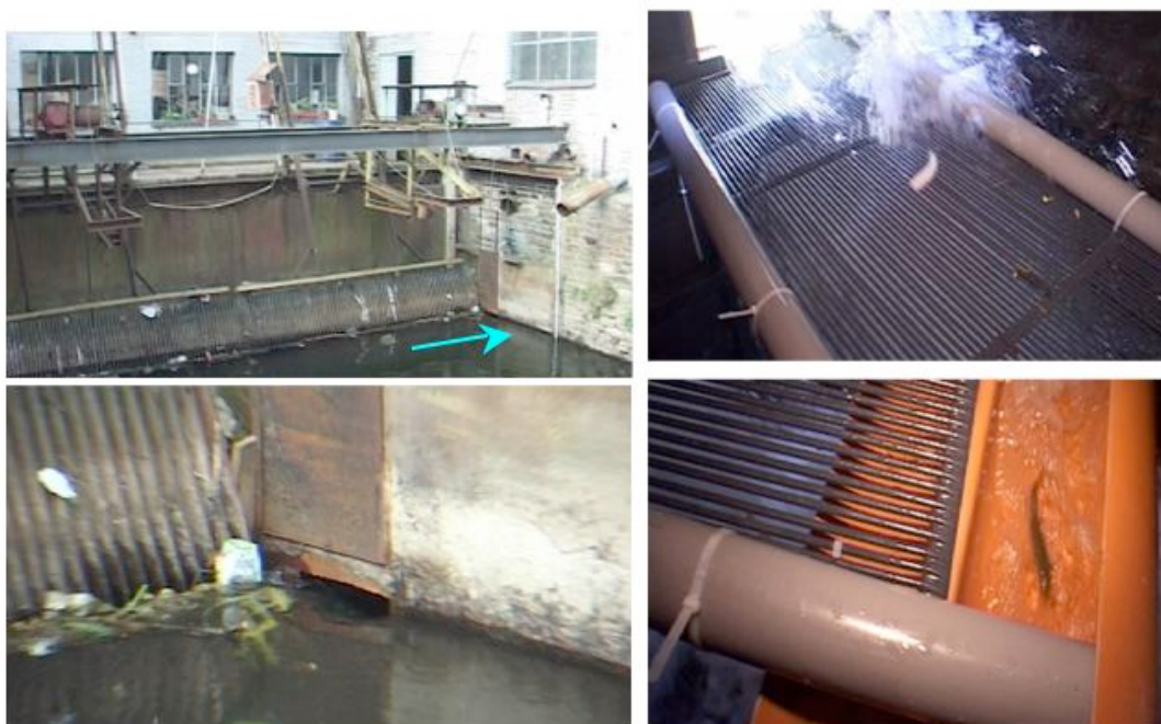
Figure 2/2 . A gauche : vue de la grille de la prise d'eau vers les turbines de M&rytherme et, dans l'angle du mur et de la grille (flèche), l'emplacement de l'exutoire de dévalaison de surface. A droite : Vue du piège installé à la sortie de l'exutoire de dévalaison..
