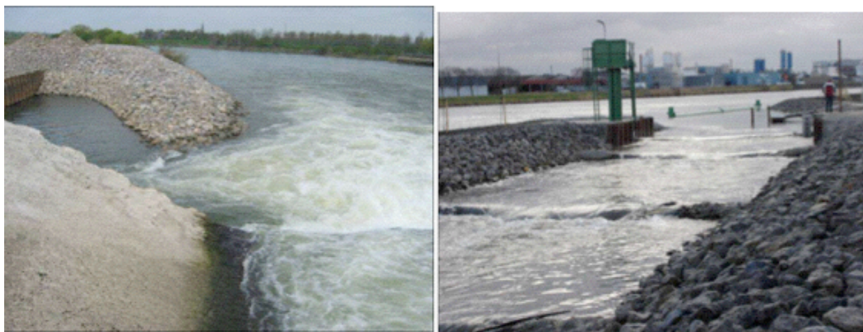
Figure 5/1. Vues de l'échelle à poissons du barrage de Borgharen-Maastricht (Pays-Bas) mise en service le 20 décembre 2007. A droite : entrée de l'eau à l'amont. A gauche : sortie en aval (source : rapport Kemper, 2008).
