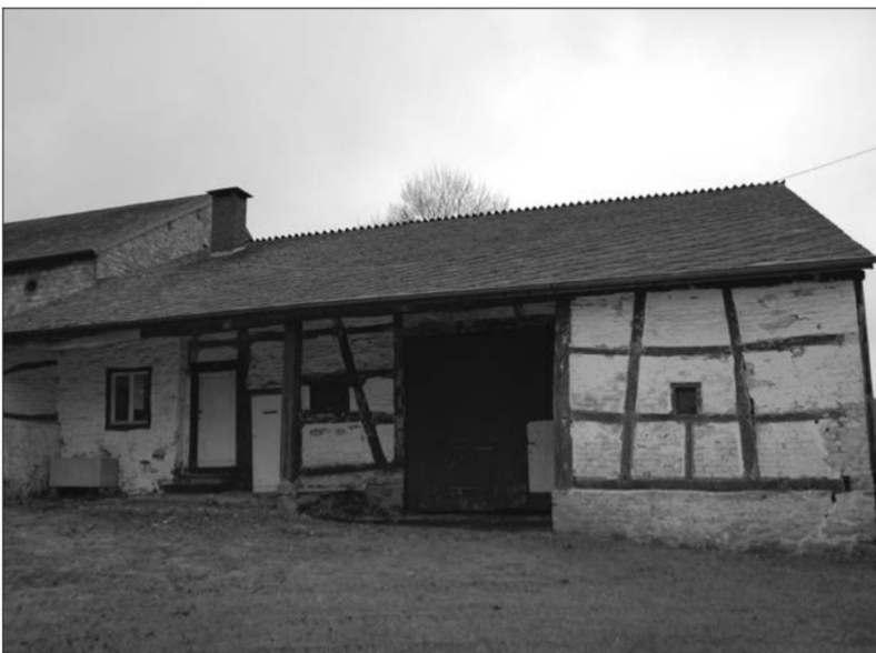
Ferme de Haute-Bodeux : la façade avant actuelle.
