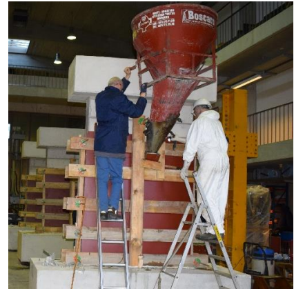
Fig. 6 Coulage chemises BFUP
