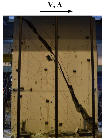
Fig. 10 Rupture du voile 1
