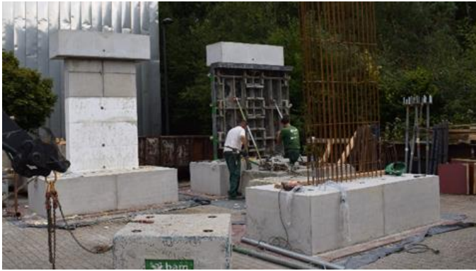
Fig. 3 Réalisation voiles BA
