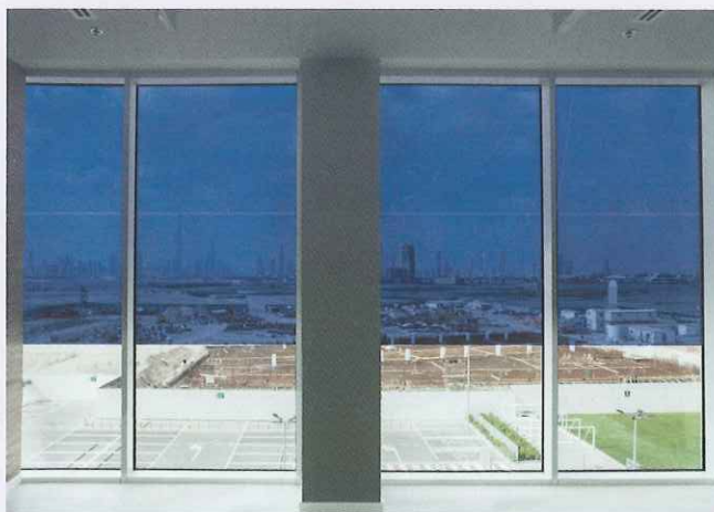
l'école scientifique internationale suisse (SISD) à Dubaï est enveloppée d'une façade électrochromique.
