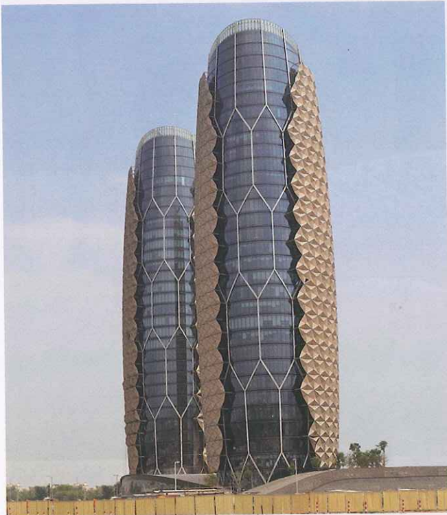
À Abu Dhabi, l'architecte des tours « Al Bahar » a misé sur des panneaux solaires devant les vitrages qui s'ouvrent et se ferment - à la façon de parapluies - selon les variations solaires.
