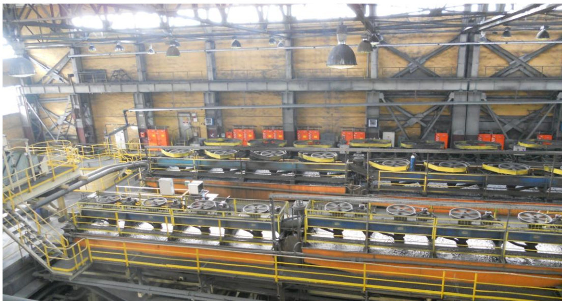
Figure 26 : image d'une partie du circuit de flottation de l'usine de Chelopech.
