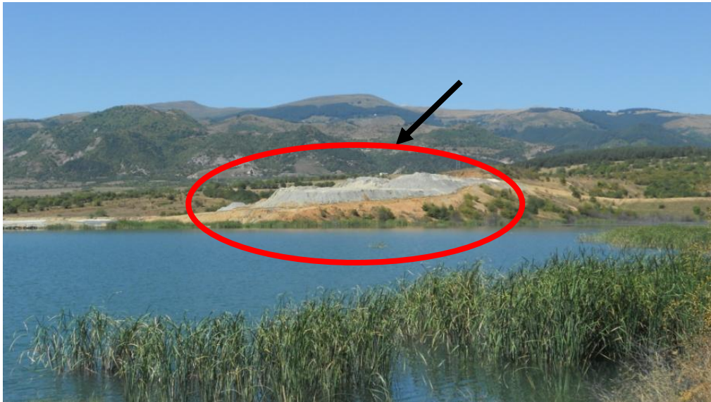
Figure 31 : Concentré de pyrite laissé à l'air libre aux abords du lac de tailings.
