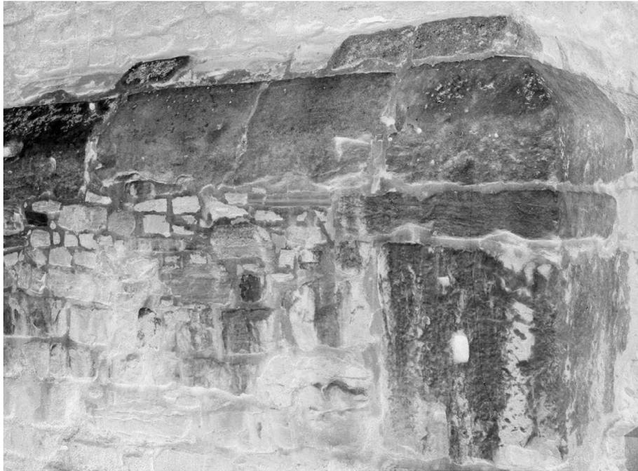
Fig. 1 : Trou de louve visible sur une pierre réemployée dans le soubassement de la tour de Notre-Dame de la Licourt à Herstal. © KIK-IRPA, cliché B033185
