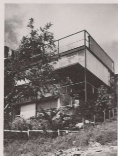
EGAU Maison Mazin, rue de Campine, Liège, 1959 Fonds architecte Charles Carlier, I.S.A. St-Luc, Liège
