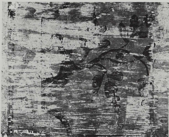
Fig. 8. — Décoration peinte sous-jacente des lambris du petit salon (n° 13) apparue lors d'un essai de dégagement. (Cliché F. Niffle, Liège.)
