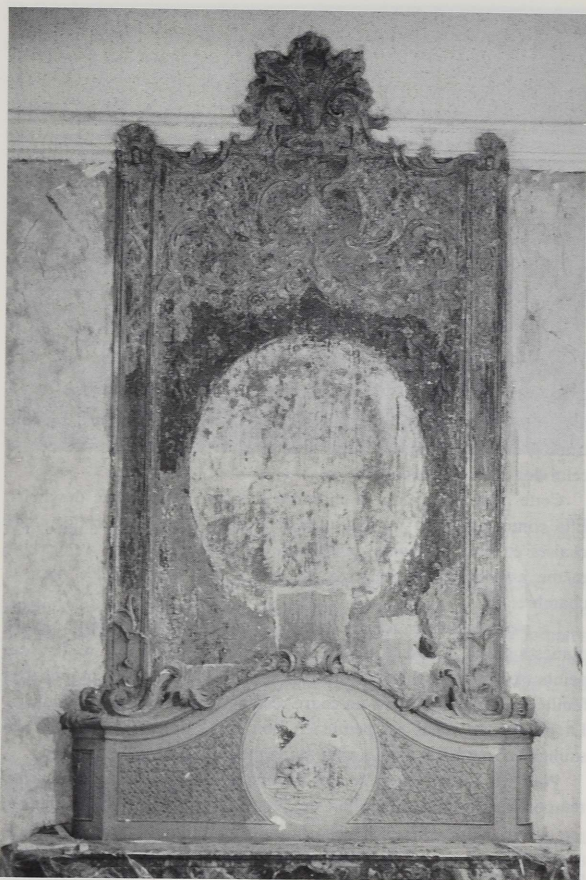
Fig. 7. — La cheminée de la chambre à coucher, lors du dégagement du décor et avant sa restauration. (Cliché F. Niffle, Liège.)
