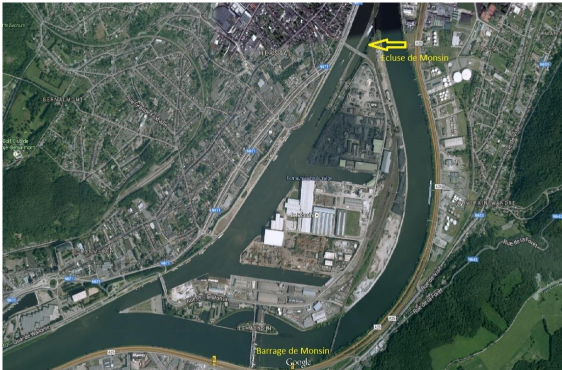
Fig.9 : Vue aérienne du barrage de Monsin et de l'écluse de Monsin par où les poissons peuvent bifurquer vers le canal Albert et remonter vers la Meuse, sans passer par l'échelle à poissons du barrage de Monsin.
