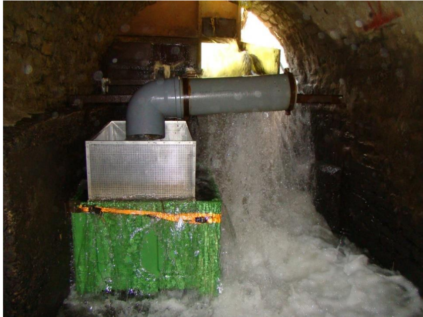
Fig.4 : Le dispositif de piégeage à la dévalaison de Méry.
