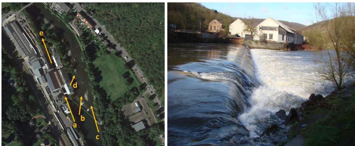
Fig.2 : Vues latérale (à gauche) et aérienne (à droite) du site du barrage de Méry avec la centrale hydroélectrique Mérytherm. Les flèches indiquent les mouvements d'eau : (a) entraînement de l'eau dans le canal de prise d'eau au fond duquel se trouvent l'entrée des deux turbines protégées par une grille et l'exutoire de dévalaison latéral, (b) l'écoulement d'eau sur le déversoir, (c) la nouvelle turbine fishfriendly en rive droite (d) la restitution de l'eau passée par l'exutoire de dévalaison et son piège à capture et (e) la restitution de l'eau turbinée (max 10 m 3 /s).
