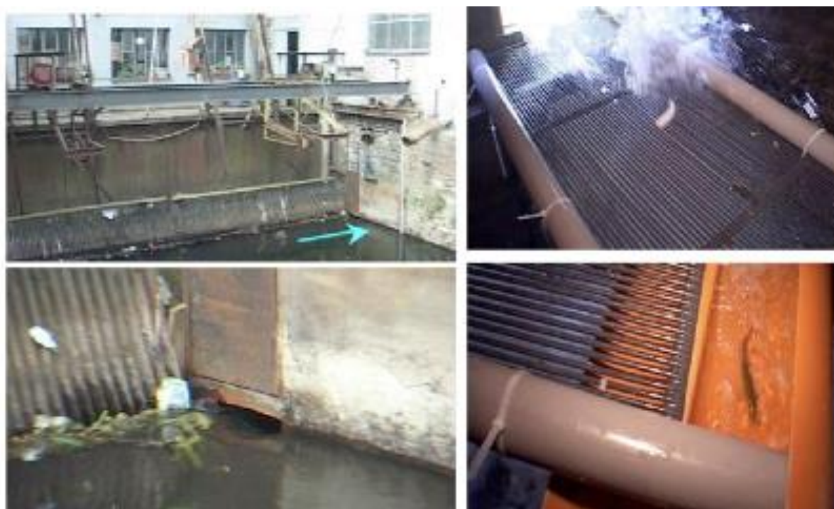
Fig.3 : Vues (à gauche) de l'exutoire de dévalaison latéral (débit : 0,1-0,2 m 3 /s ; vitesse : 1-1,2 m 3 /s) aménagé dans le prolongement latéral de la grille de la prise d'eau de la centrale hydroélectrique Merytherm (10 m 3 /s maximum) sur l'Ourthe et (à droite) du système de récupération des poissons.
