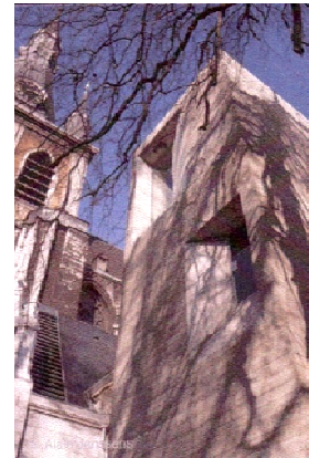
Figure 34 : La tourelle d'escalier en béton armé. (Janssen, 2009)
