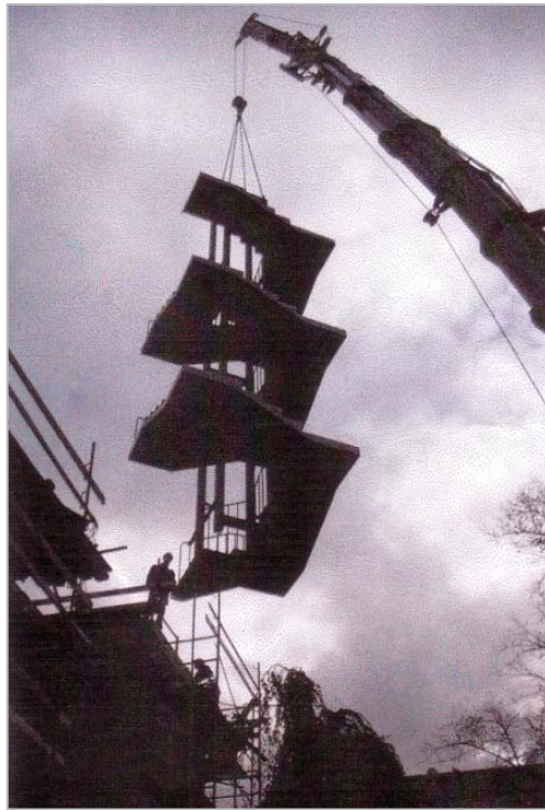
Figure 44 : La pose de l'escalier de secours en acier corten. (Janssen, 2009)
