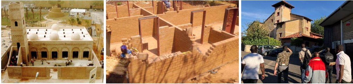
Fig. 6. Quelques réalisations en BTC. De gauche à droite : la Mosquée Al Medy à Ryad en Arabie Saoudite ; un chantier en BTC à Lubumbashi en R.D. Congo ; une maison en BTC à L'Isle-d'Abeau en France (Anger et Fontaine, 2009 ; Caritas Lubumbashi, 2011).
