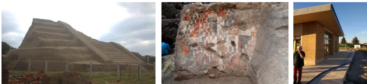
Fig. 3. Illustration de quelques moyens de lutte contre la détérioration d'une construction en terre crue. De gauche à droite : vestige de la pyramide en terre crue de La Joya au Mexique (1 er siècle) ; vestige d'un mur enduit à Dja'de el Mughara en Syrie (9 ème siècle av. J.-C) ; maison en pisé avec un toit débordant et un soubassement en béton de ciment construite en 2018 à Villefontaine en France (Daneels, 2008 ; Moriset, 2018).
