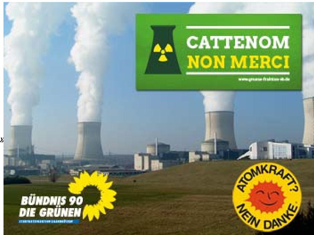
Placard des Verts contre la centrale nucléaire de Cattenom
