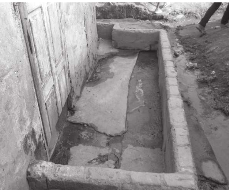
Exemple de technique d'adaptation : véranda surélevée.
