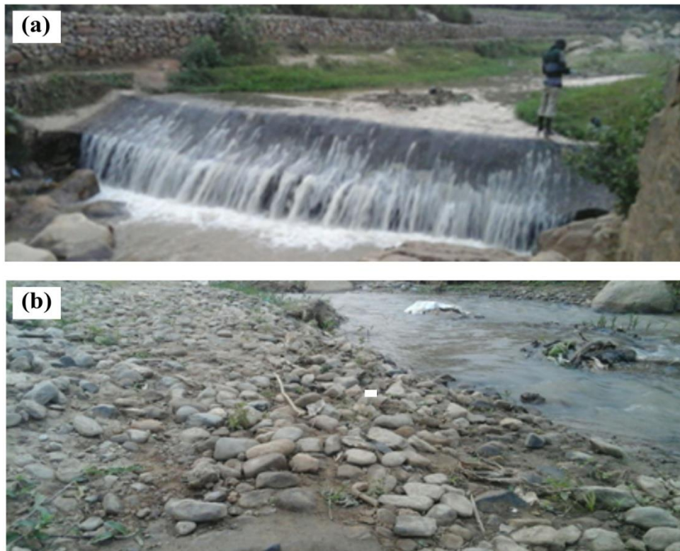
Figure 5.1. (a) Petite chute d'eau sur une ancienne structure de régulation des crues (situé à 270 m en aval de la section transversale 3 montrée à la Fig. 5.2). (b) Vue du lit de la rivière pendant la saison sèche avec présence de galets (d'un diamètre moyen de l'ordre de 20-30 cm) et de rochers fins déposés après les inondations pendant la saison des pluies.
