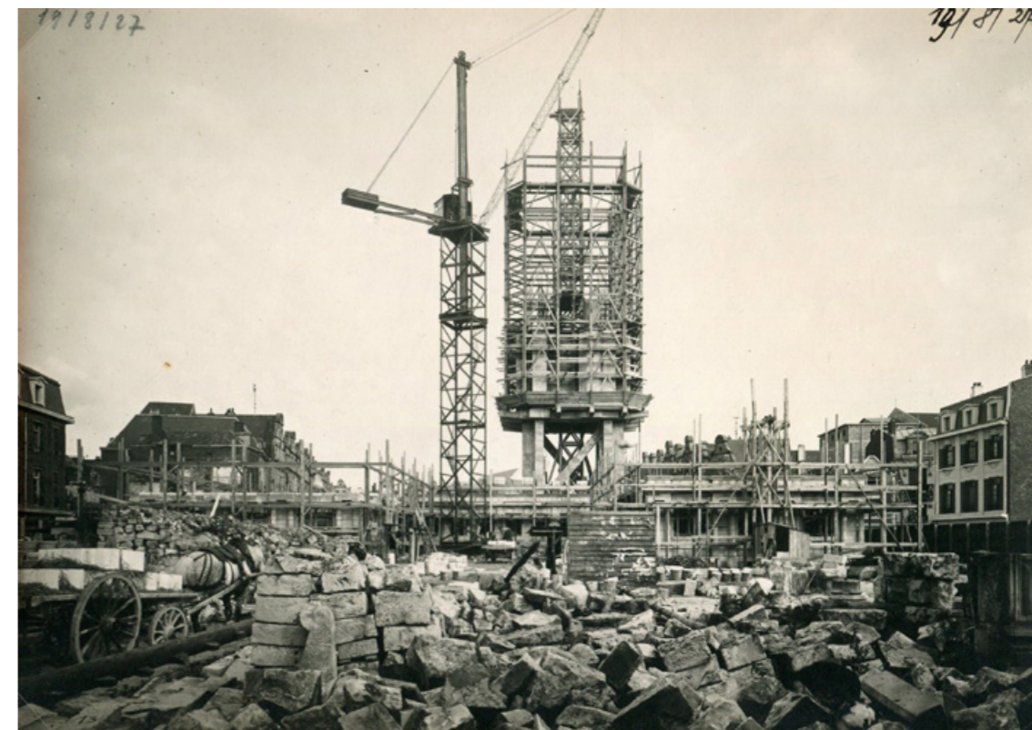
Fig. 5 Début de la reconstruction du beffroi le 19 août 1927, photographie, Bibliothèque d'histoire locale, Arras.
