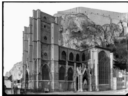
Fig. 2 Dinant, église Notre-Dame, toiture emportée par l'incendie de 1914. © Bruxelles, KIK-IRPA, cliché allemand, 1917-1918, B017779.
