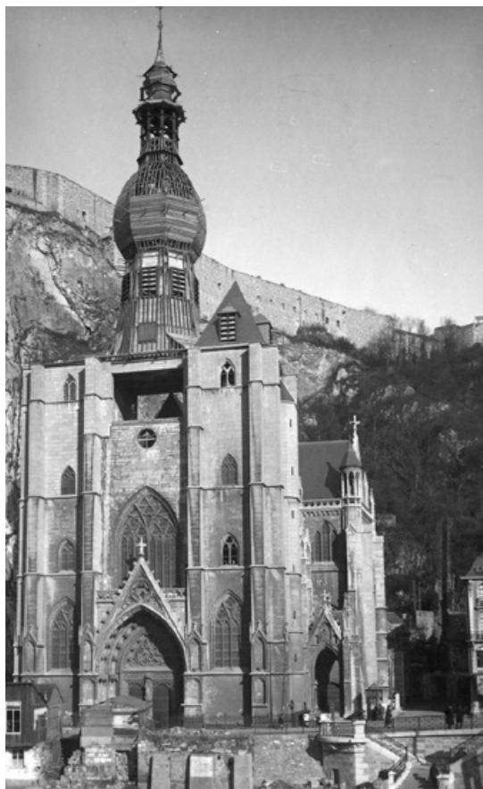
Fig. 20 Le clocher bulbeux en cours de reconstruction, vers 1925-1927. © Liège, Musée de la Vie wallonne, cliché 1018623.
