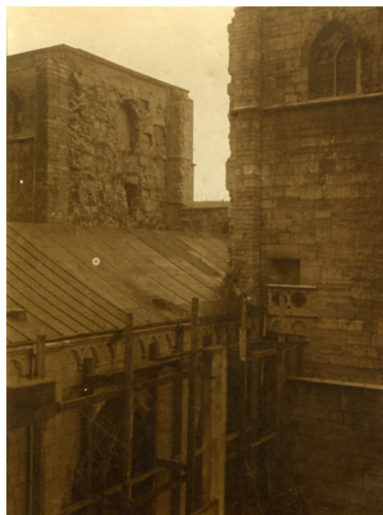
Fig. 13 La collégiale en cours de restauration, vers 1920-1922. © Liège, Centre d'Archives et de Documentation de la CRMSF, fonds de la CRMSF.
