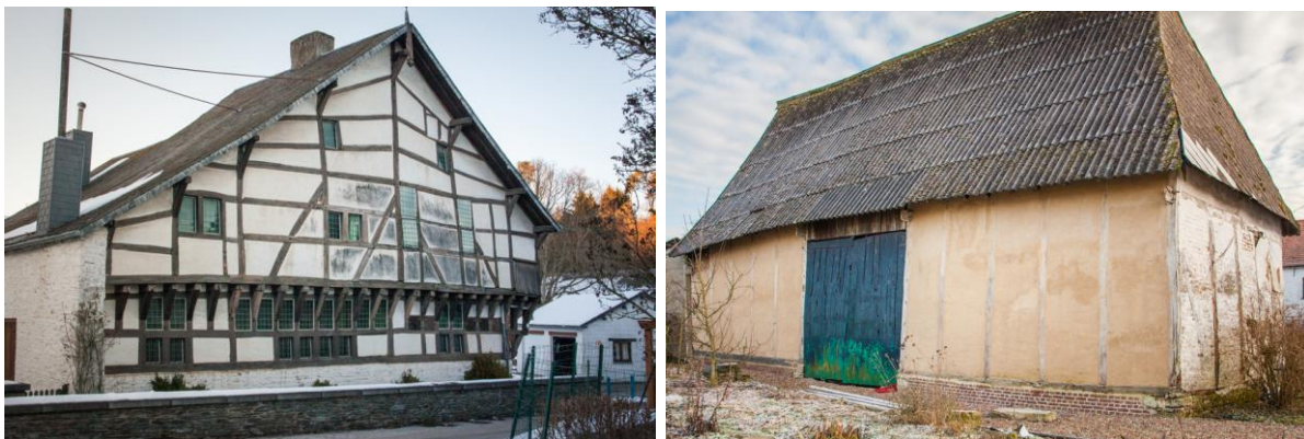
Fig. 16. Exemples de construction en torchis. À gauche la maison espagnole à Groupont (XVIème siècle), à droite une grange à Saint-Sauveur (XIXème siècle) (Pereira-Goncalves, 2017).
