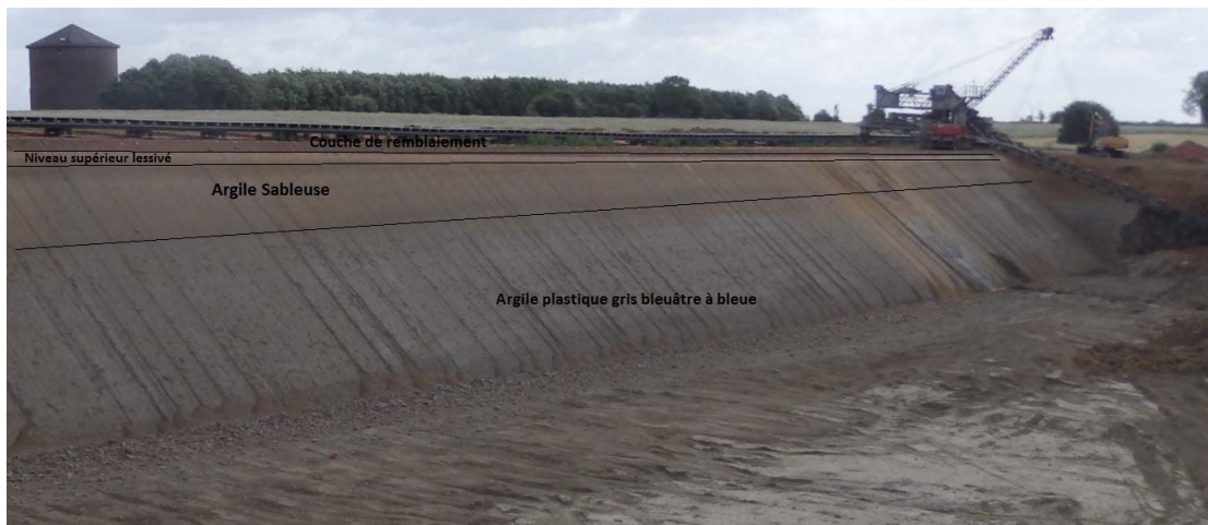
Fig. 86. Section à travers l'argilière de Barry montrant les différentes couches argileuses.
