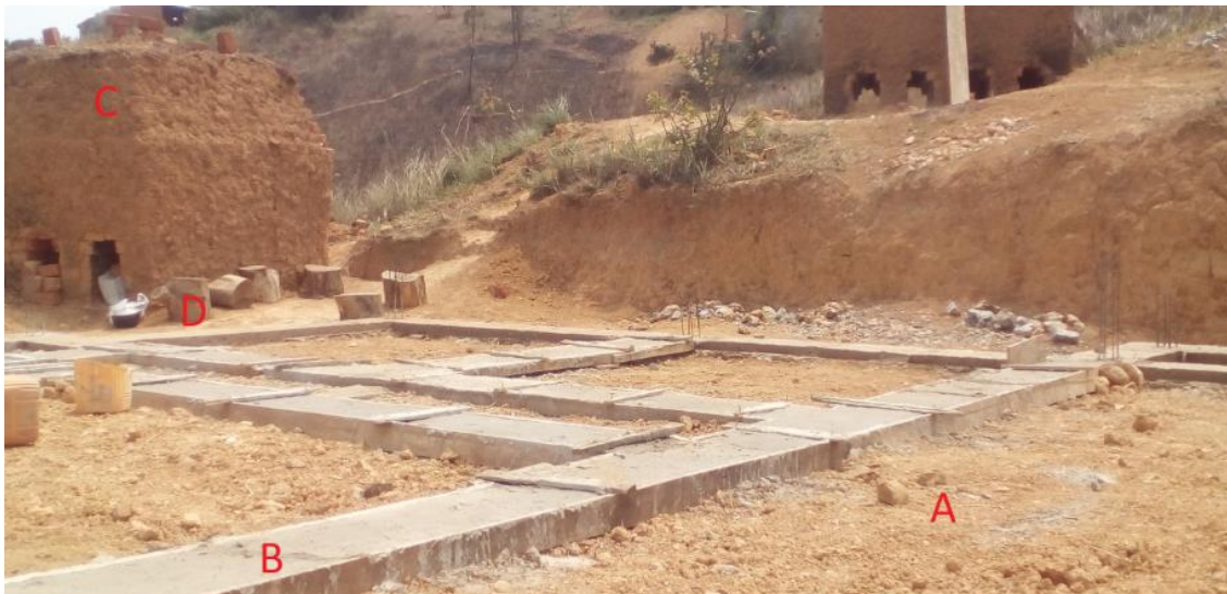
Fig. 100. Exemple de construction. A. parcelle à construire : il s'agit de la zone d'où a été extraite la terre pour faire les briques. B. Fondation de la nouvelle maison faite de pierre et de sable de la région et du ciment produit dans la province. C. Four traditionnel pour cuire les briques. Ce four utilise le bois comme combustible. D. Bois de combustible.
