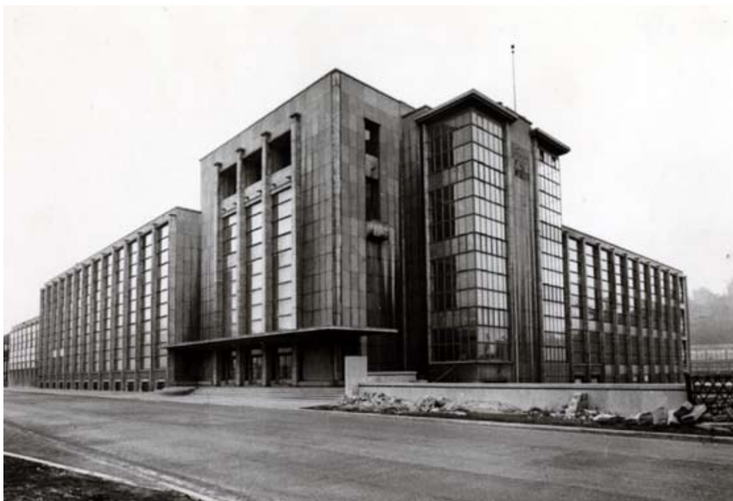
Institut de Génie civil inauguré en 1937 – Façade est du quai Banning Architecte Joseph Moutschen © Collections artistiques de l'Université de Liège
