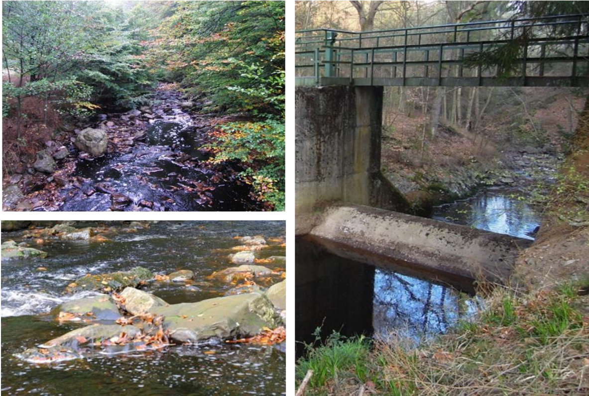
Figure 21 : Photos du secteur inventorié sur le Getzbach avec le barrage comme point amont (photo de droite)
