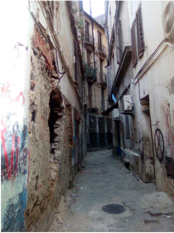
Figure 1 : L'état de dégradation de la Médina d'Annaba
