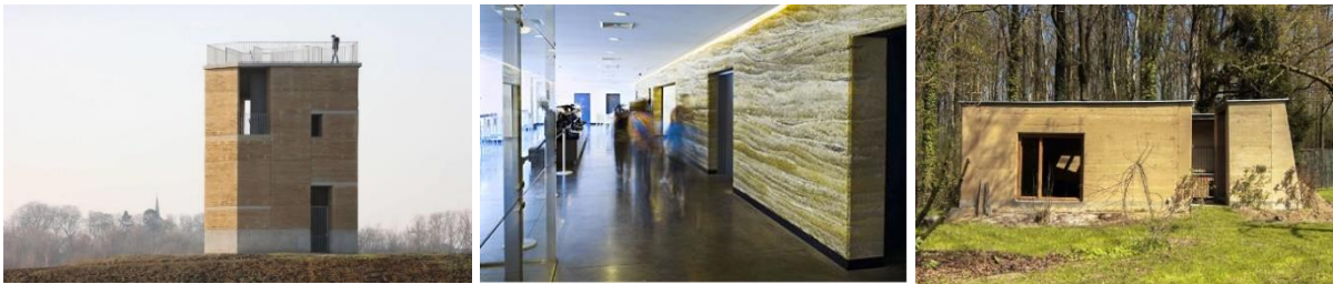
Fig. 14. Exemples des constructions récentes en pisé en Belgique. De gauche à droite : tour d'observation de Negenoord, mur intérieur du musée Source O Rama à Chaufontaine, pavillon de chasse à Alost (Claytec, 2004 ; Inhabitat 2016a et 2016b).
