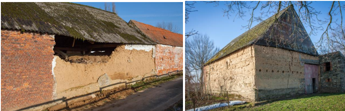
Fig. 15. Étable (à gauche) et grange (à droite) en bauge à Braine-le-Comte (Pereira-Goncalves, 2017).
