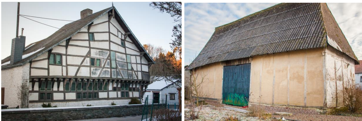
Fig. 16. Exemples de construction en torchis. À gauche la maison espagnole à Groupont (XVIème siècle), à droite une grange à Saint-Sauveur (XIXème siècle) (Pereira-Goncalves, 2017).
