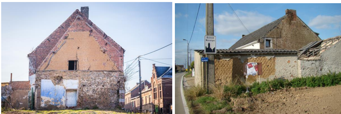
Fig. 17. Mur intérieur d'habitation du XIXème siècle à Estinnes (à gauche) et Remise à Wasseiges (à droite) en adobes (Pereira-Goncalves, 2017).
