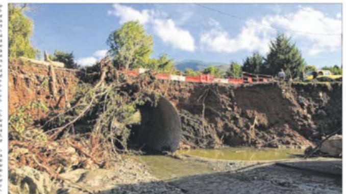
La crue a été accentuée par un bouchon de végétation qui, en débâcle, a rongé la route, détruit un pont, un chemin d'accès et le chalet familial des Leccia, construit par leur aïeul.
