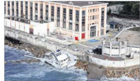
À Saint-Joseph à Ajaccio, un catamaran s'est brisé sur les rochers.
