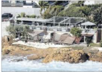
Sous le restaurant Cher Pech à Barlicaggi, sur la route des Sanguinaires à Ajaccio, la palissade et les trepanons n'ont pas résisté à l'assaut des vagues.
