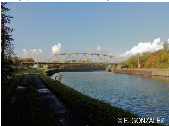
Photographie T5.3 : RAVeL 3, le long du canal Bruxelles-Charleroi
