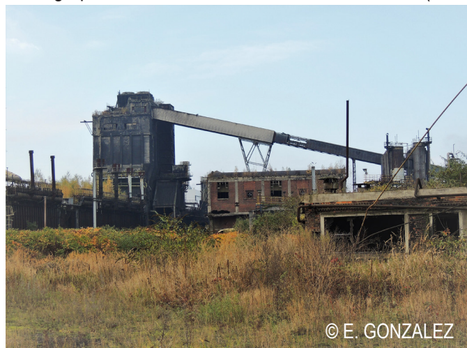
Photographie T6.1 : Site désaffecté Carsid Duferco (Marcinelle)
