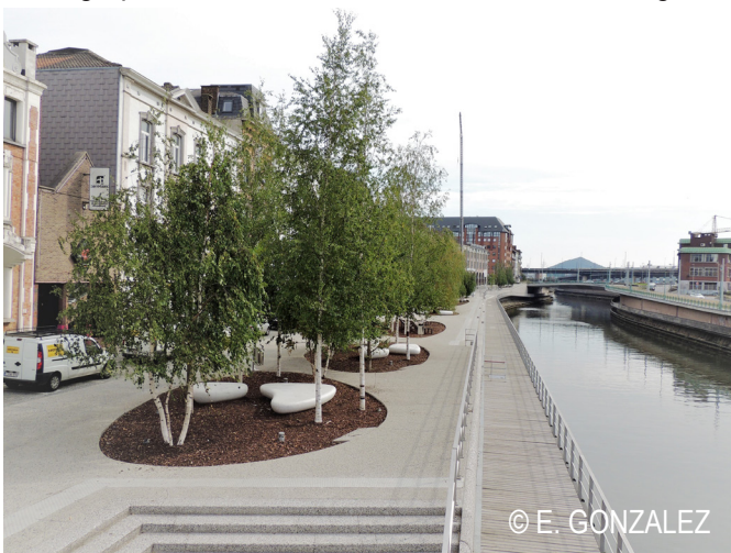
Photographie T5.2 : Quai Arthur Rimbaud réaménagé le long de la Sambre
