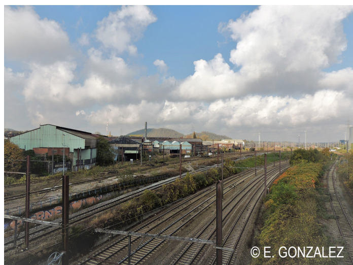
Photographie T4.3 : Ligne de chemin de fer (Charleroi ouest), prise depuis le pont de la Rue du Port en direction de Monceau-sur-Sambre
