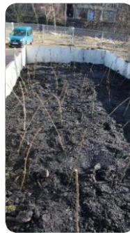
Mise en place de l'unité
