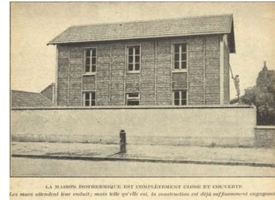
Maison Feuillette en construction (Science et Vie n°56, 1921) (site des Compailleurs)
