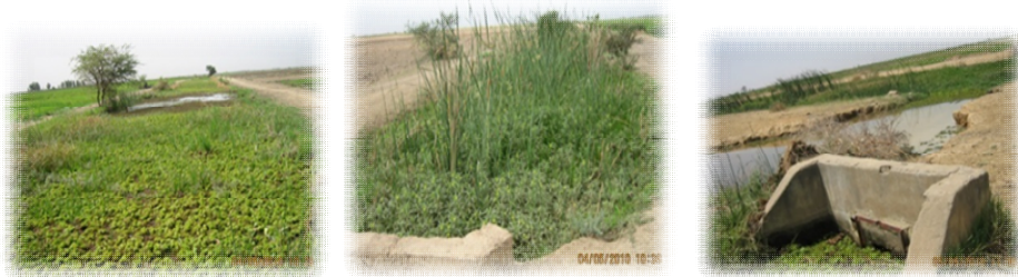
Image 2 : Canaux tertiaires dégradés à l'ON.
