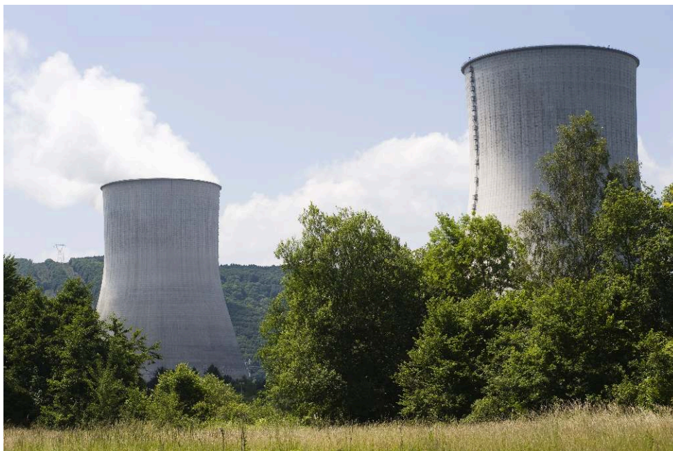
Tours de refroidissement des réacteurs de la centrale nucléaire de Chooz.
