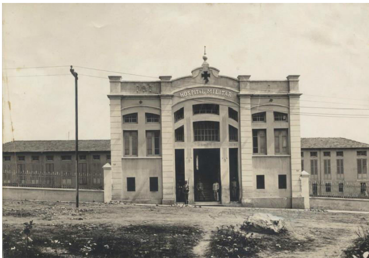
Figura 5 – Fachada do Hospital da Força Pública de Minas Gerais
