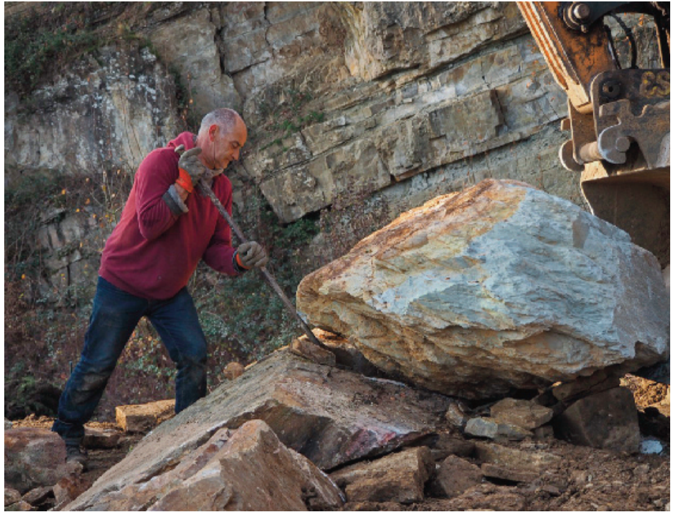
Paolo Gasparotto installe un énorme bloc de quartzite cambrien à la base du mur géologique.
